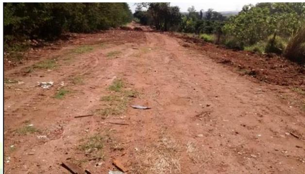
Figura 24 - Uso dos resíduos da construção civil na recuperação de estradas rurais
