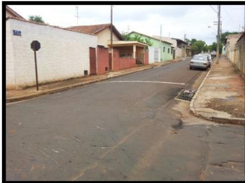
Figura 68 - Bocas de leão com grades desobstruídos e em bom estado de conservação
