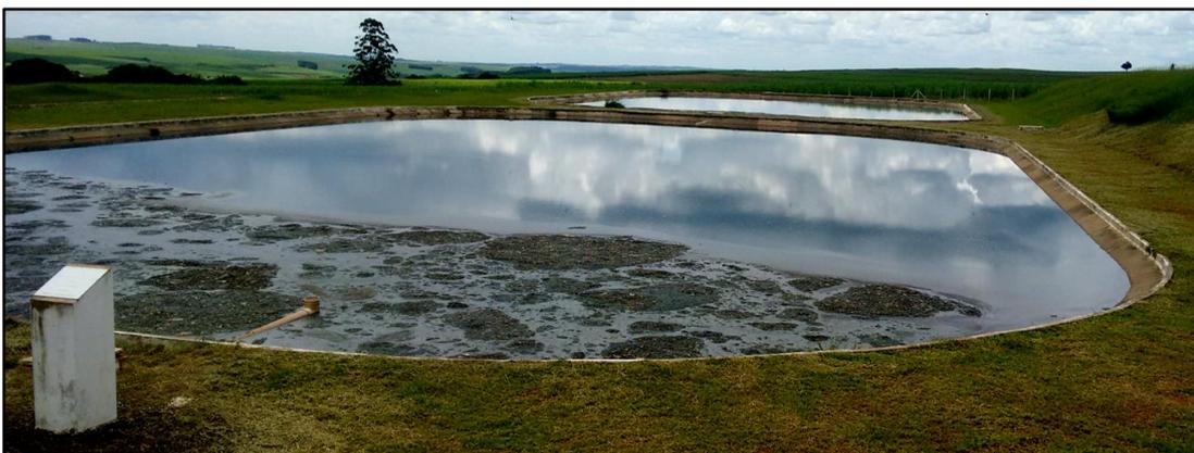
Figura 56 - Lagoas Anaeróbias – Detalhe para o Lodo acumulado
