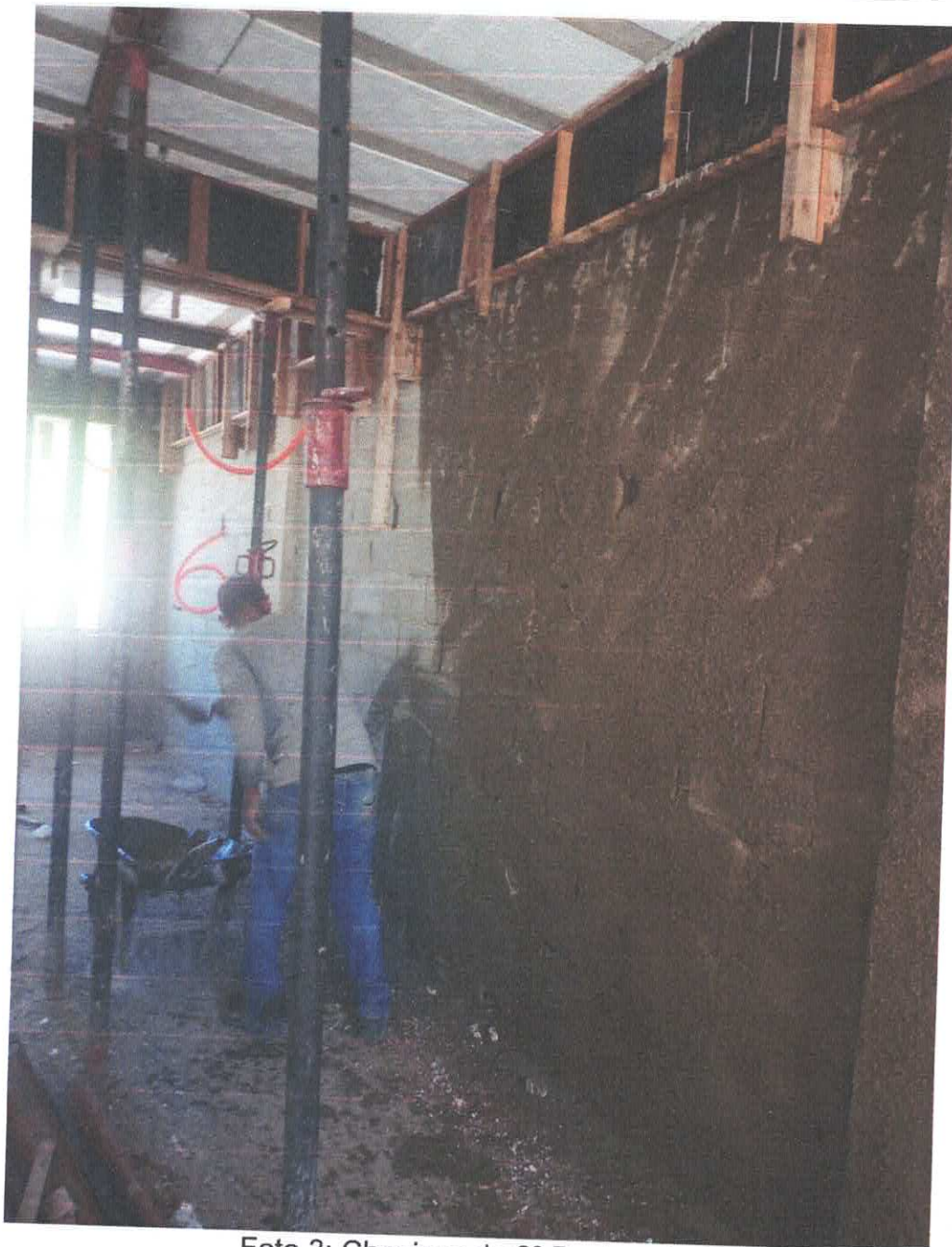
Foto 3: Chapisco do 2º Pavimento
