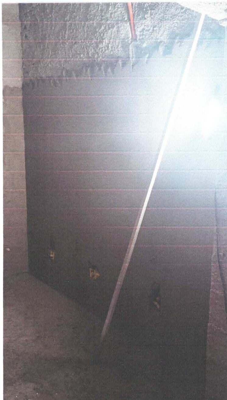
Foto 5: Reboco e emboço do 1º Pavimento
