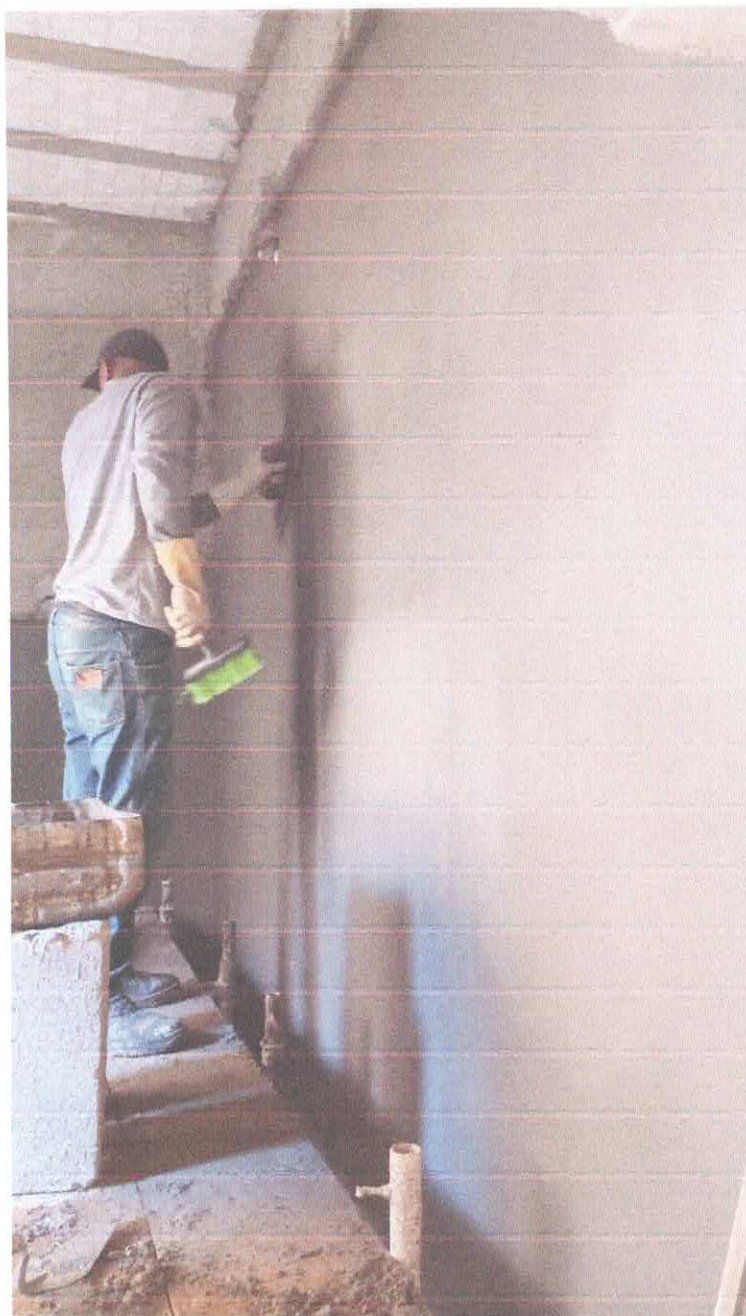
Foto 6: Reboco e emboço do 1º Pavimento
