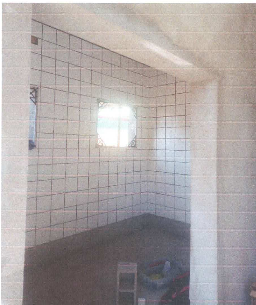
Foto 1: Assentamento do revestimento cerâmico no 1º Pavimento
