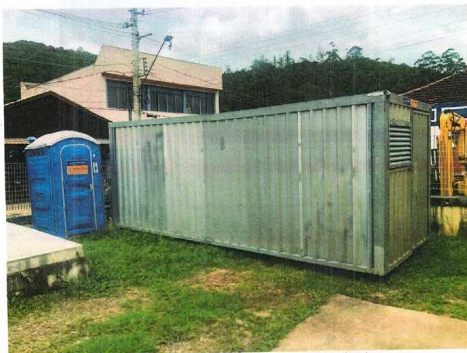
Foto 5. :Instalação de container no canteiro de obra.
