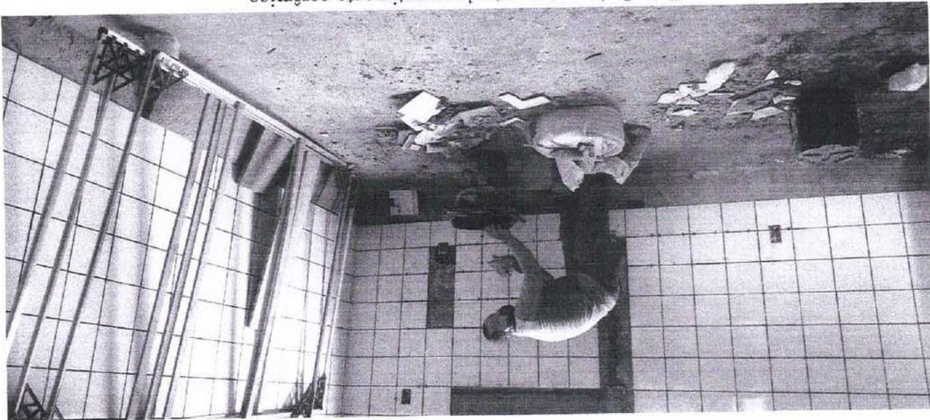
Foto 5: Assentamento de revestimento cerâmico
