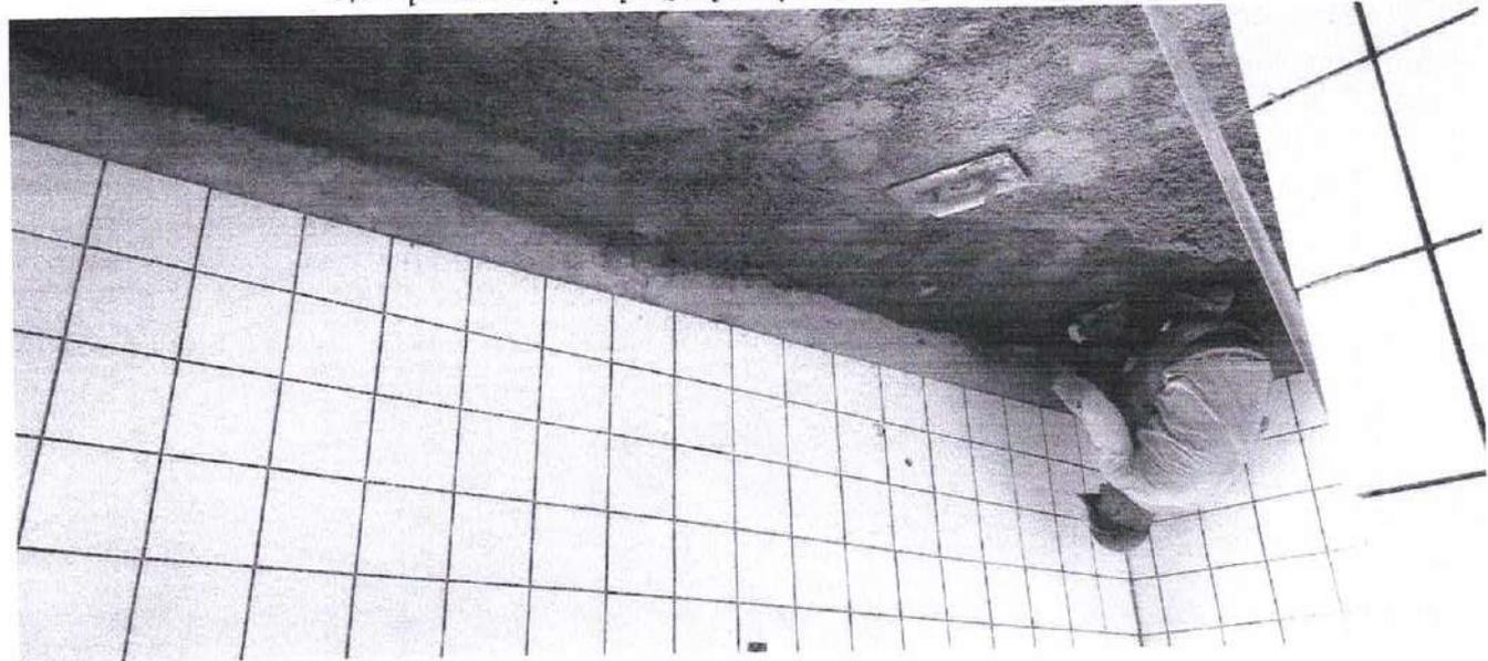
Foto 4: Contrapiso para a instalação dos pisos porcelanato
