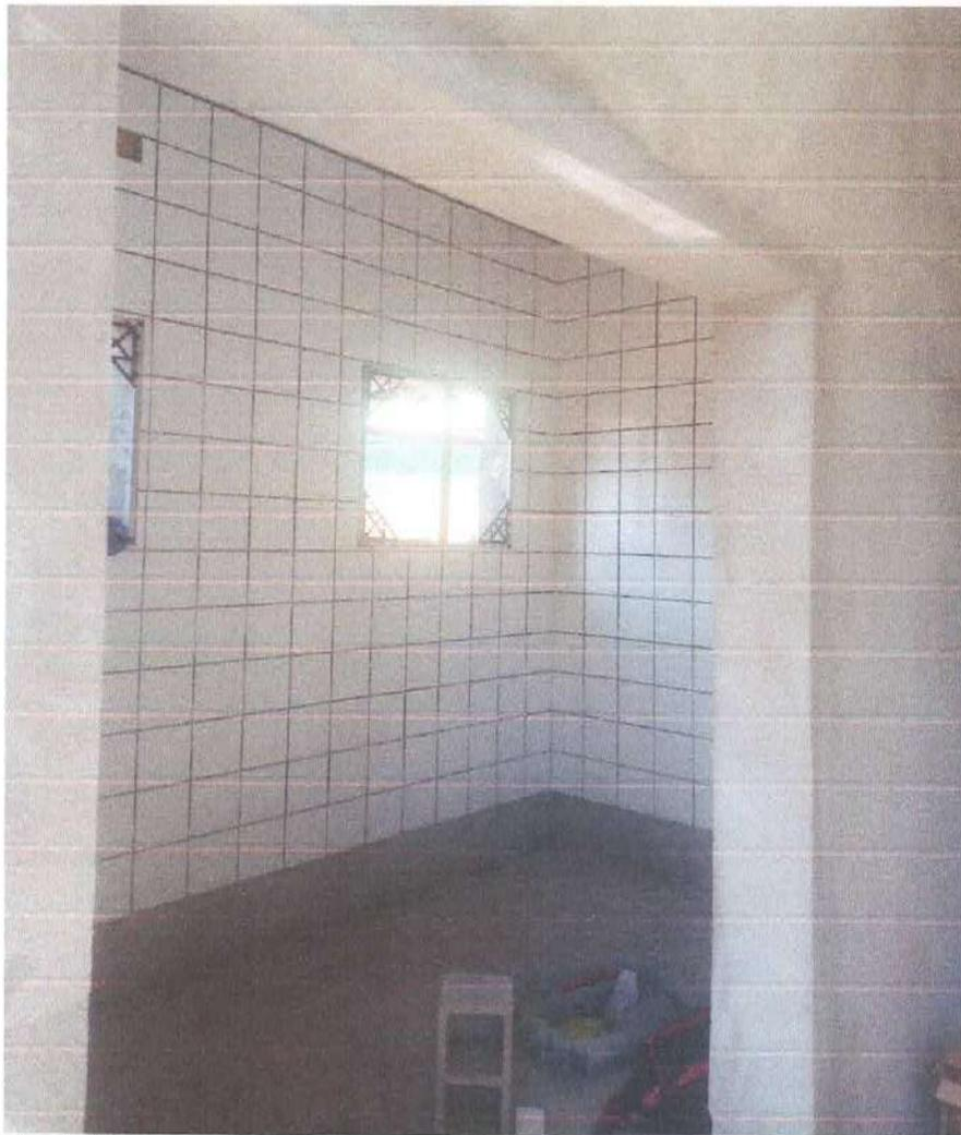
Foto 1: Assentamento do revestimento cerâmico no 1º Pavimento
