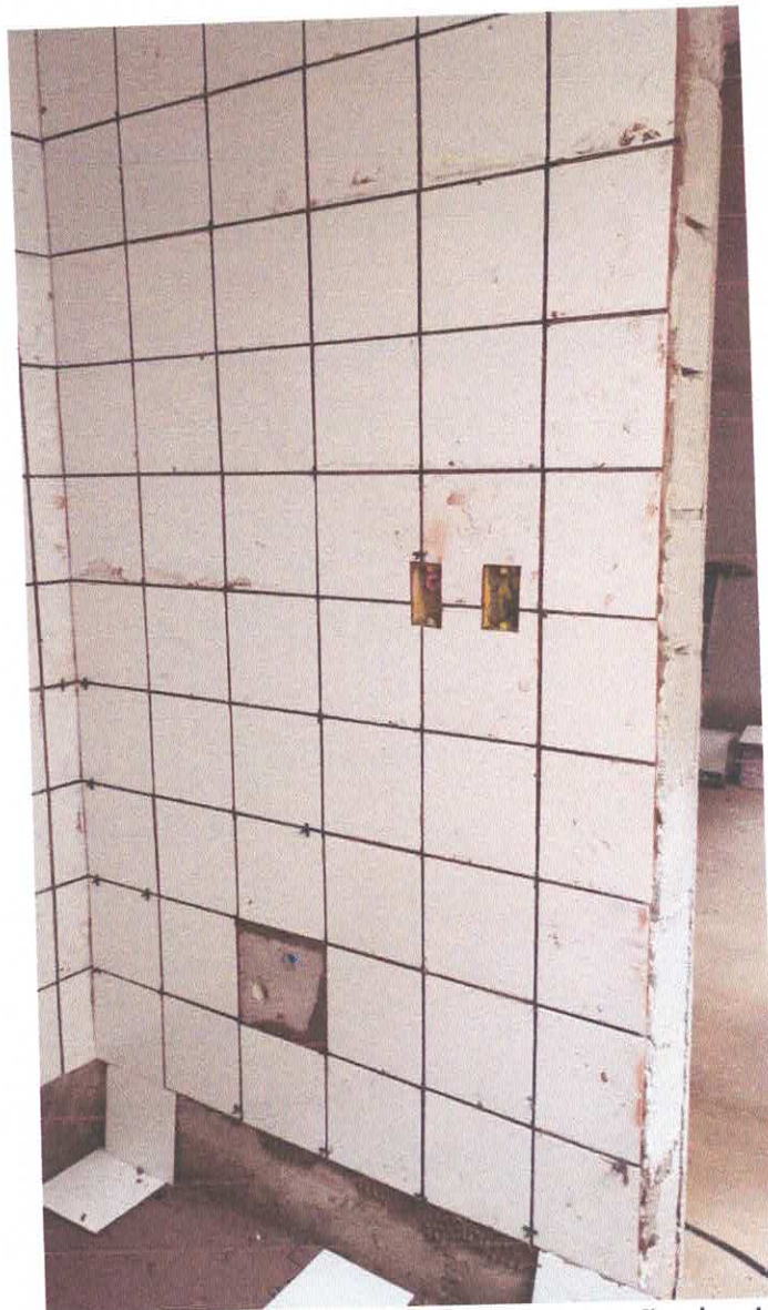
Foto 6: Assentamento de revestimento cerâmico e preparação das tomadas e interruptores
