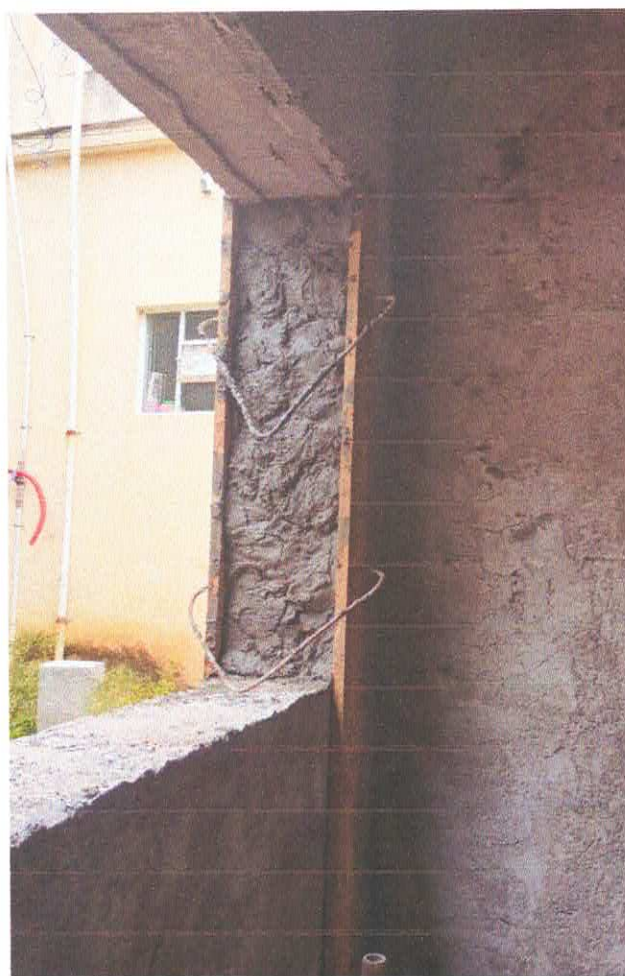
Foto 1: Requadro das janelas para instalação de peitoril e contramarco
