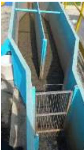
**Figura 82:** Sistema de gradeamento seguido de desarenador.
