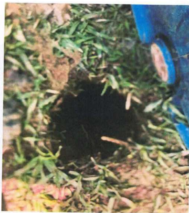
Foto 3.: Perfuração da sondagem
