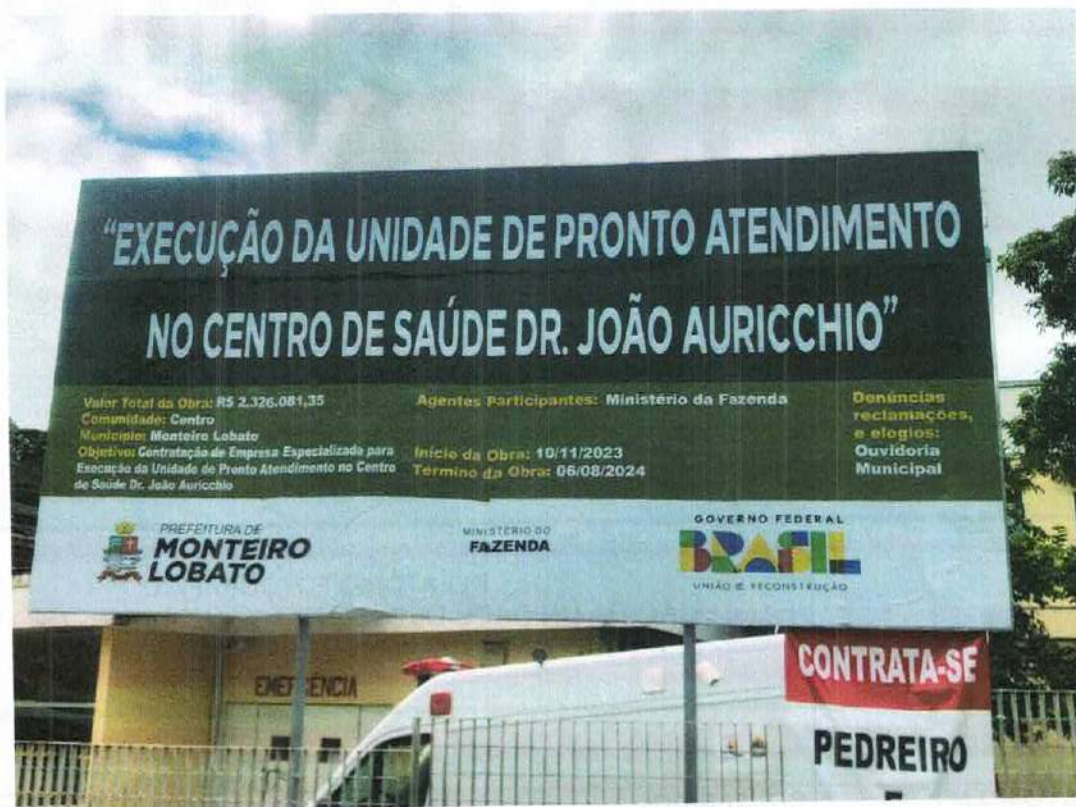
Foto 1: Correção da placa de obra.
