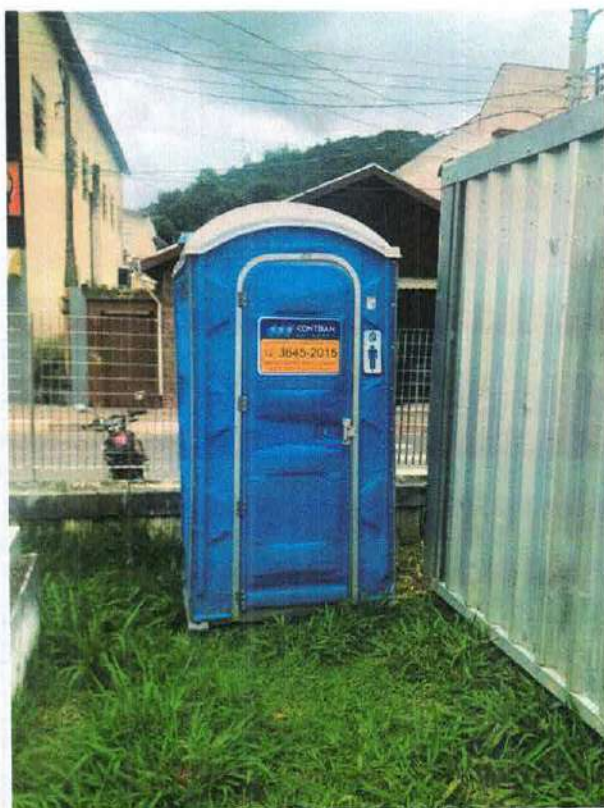
Foto 4.: Instalação de banheiro químico no canteiro de obra
