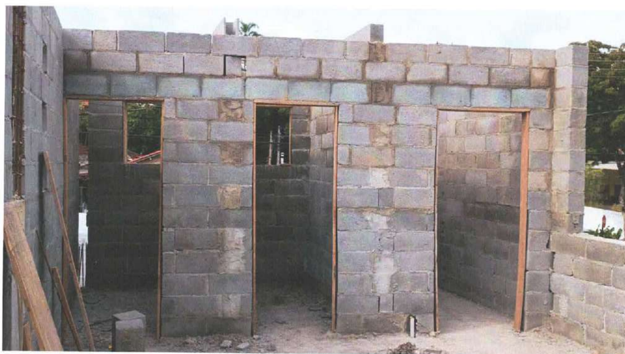
Foto 3: Alvenaria do 2º Pavimento
