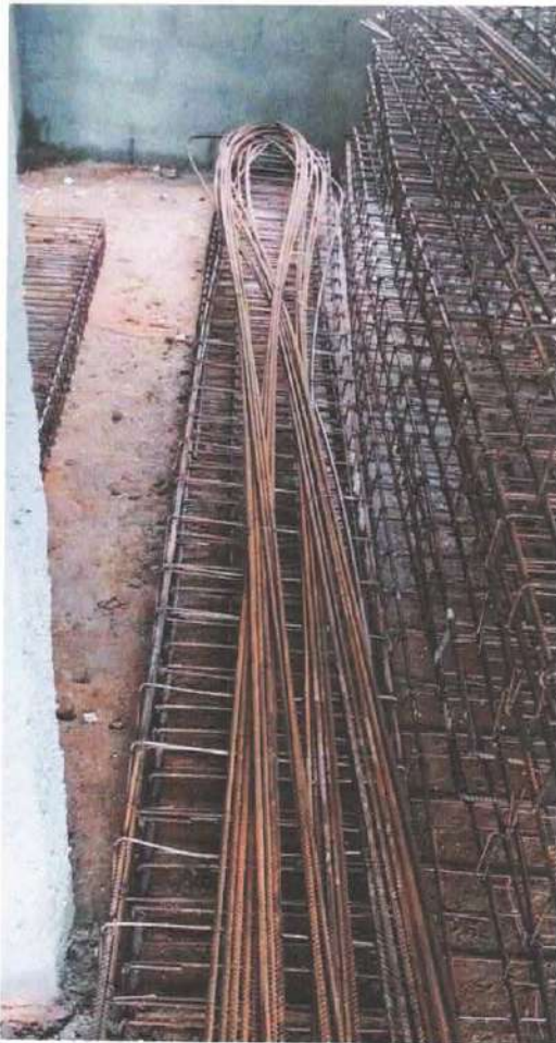
Foto 1: Ferragem das vigas e pilares
