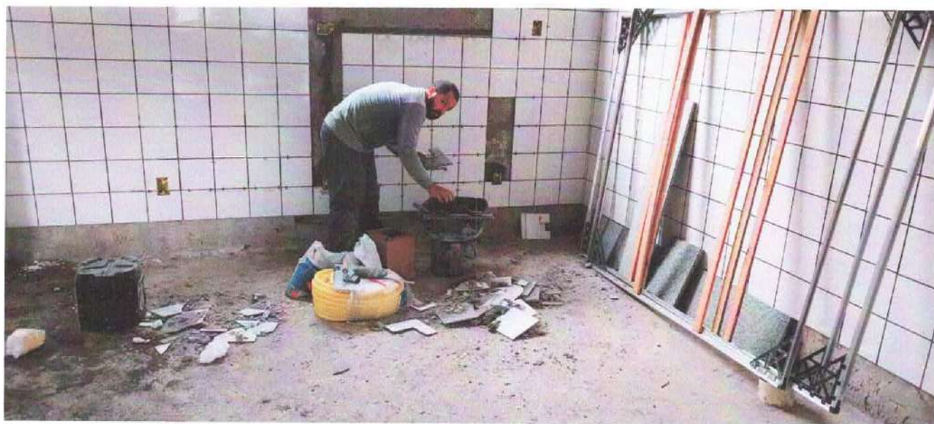
Foto 5: Assentamento de revestimento cerâmico
