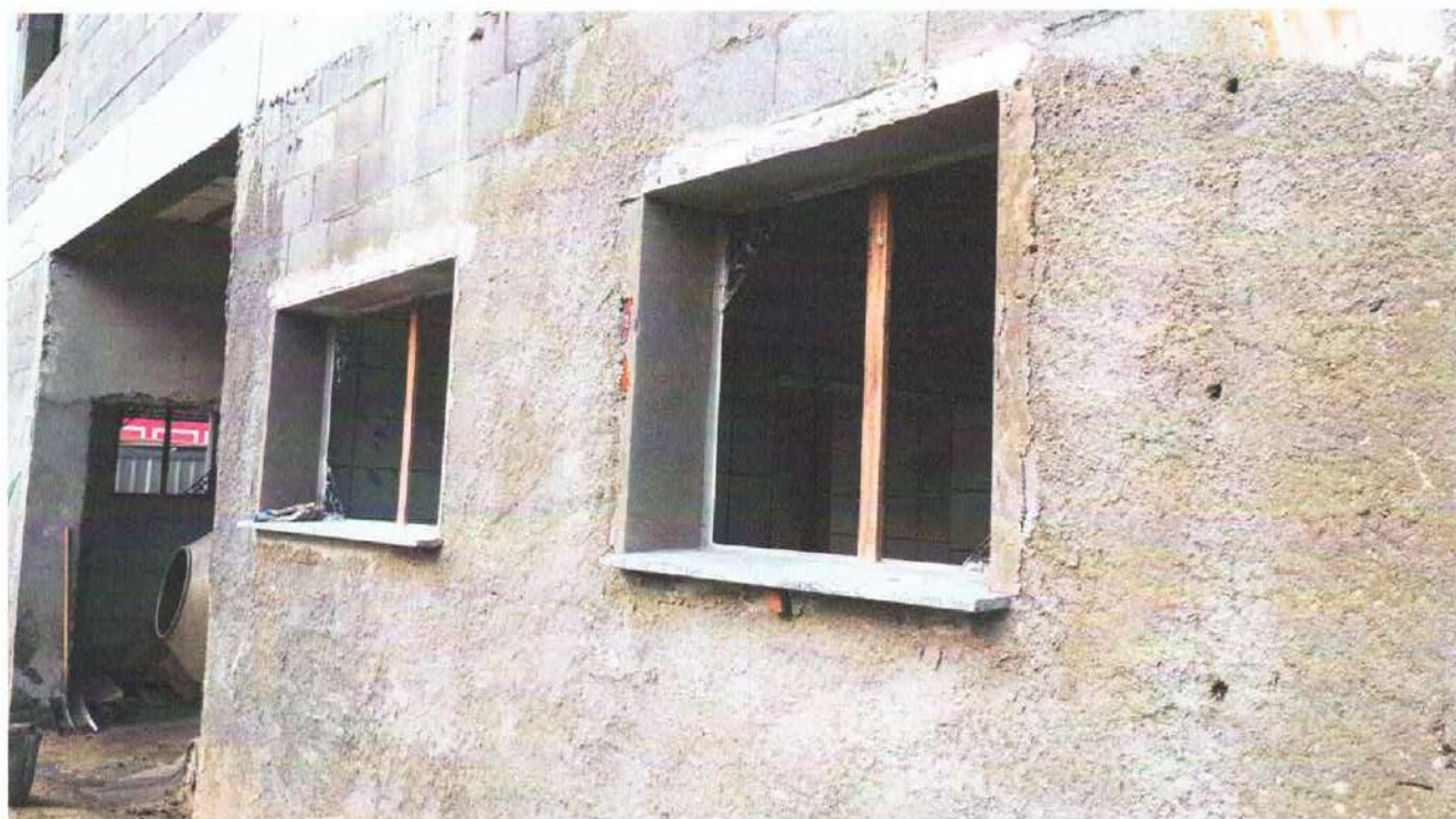
Foto 3: Assentamento de peitoril, requadro das janelas do primeiro pavimento
