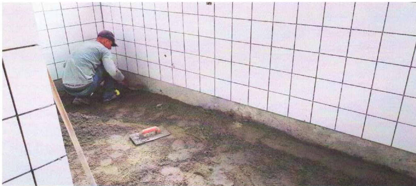
Foto 4: Contrapiso para a instalação dos pisos porcelanato
