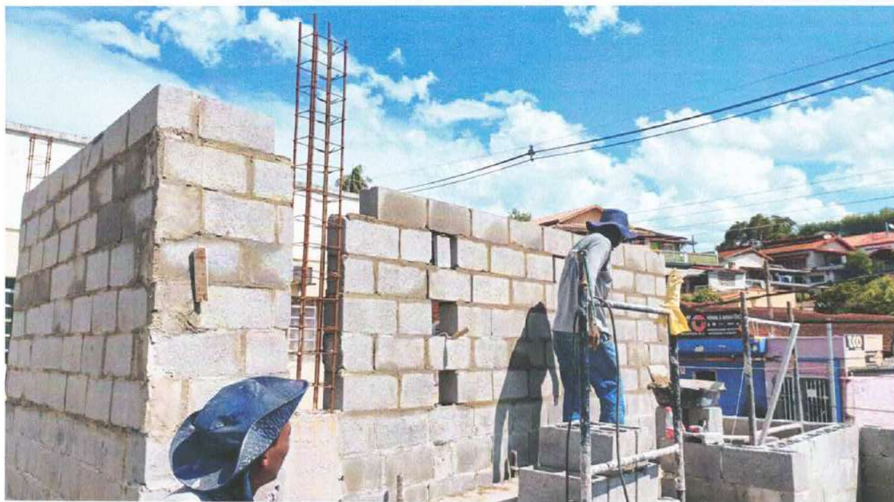
Foto 4: Alvenaria do 2º Pavimento
