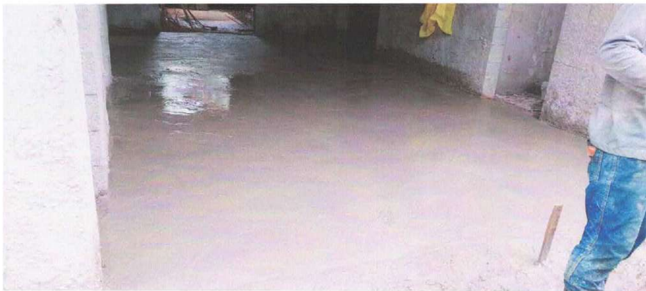
Foto 6: Concretagem do piso do 1º Pavimento
