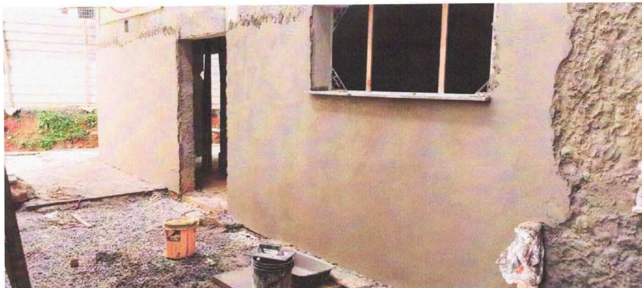
Foto 2: Reboco das paredes externas
