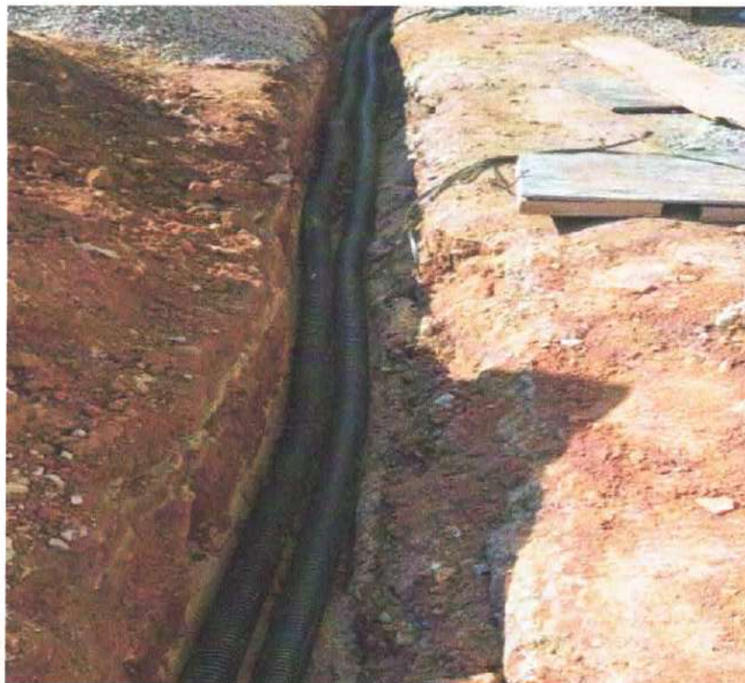
Foto 10: Instalação de infraestruturas elétricas.
