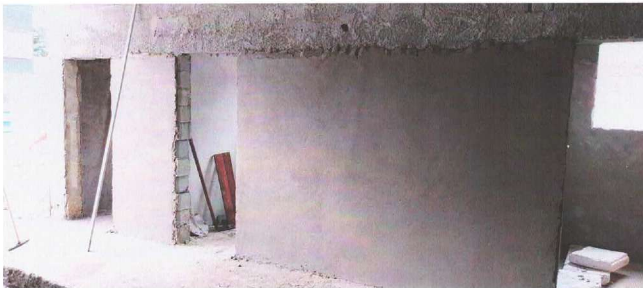
Foto 8: Reboco do 1º Pavimento
