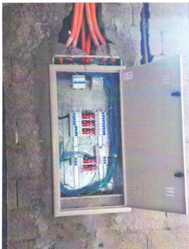
Foto 8: Instalação de quadro e disjuntores.
