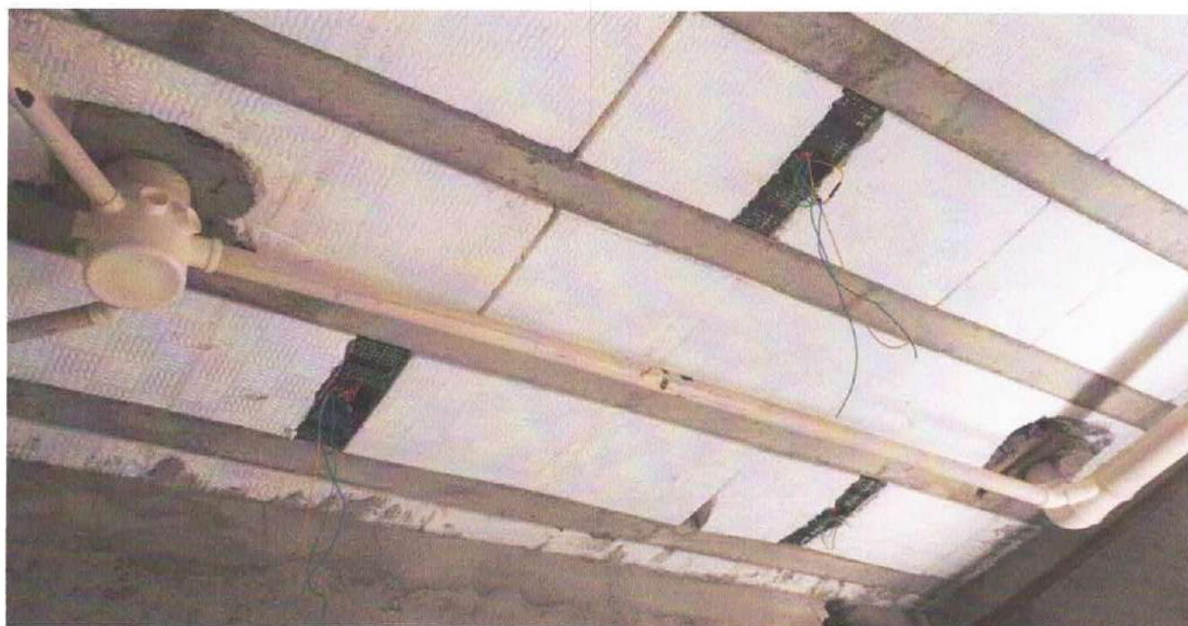
Foto 9: Instalação hidráulicas e elétricas.
