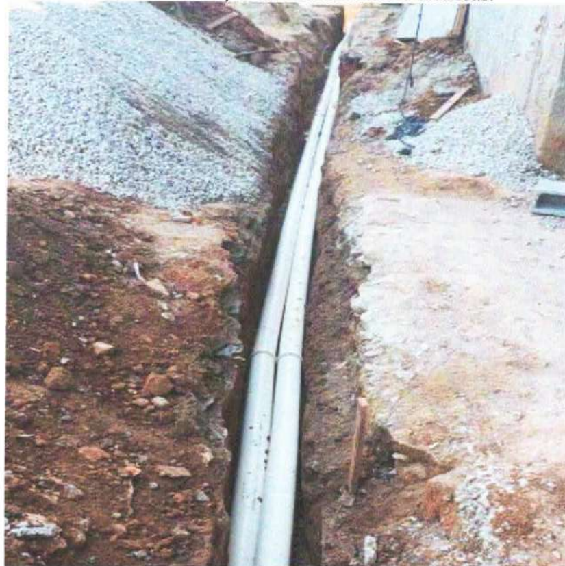
Foto 11: Instalação de infraestruturas hidráulicas.
