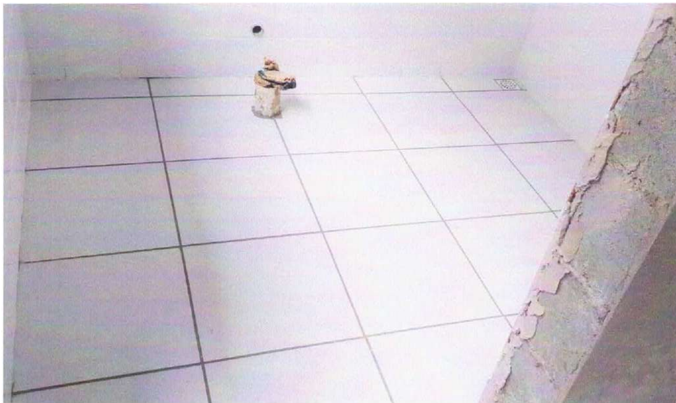
Foto 12: Instalação de piso cerâmico.
