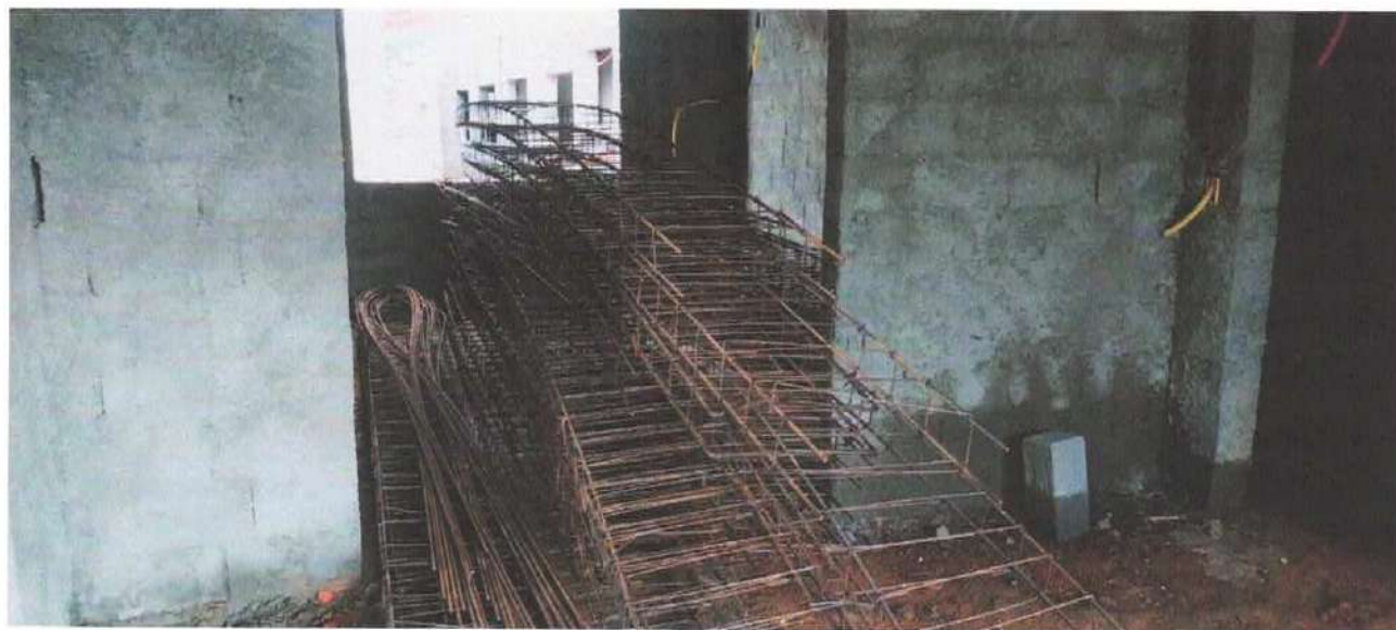
Foto 2: Ferragem das vigas e pilares
