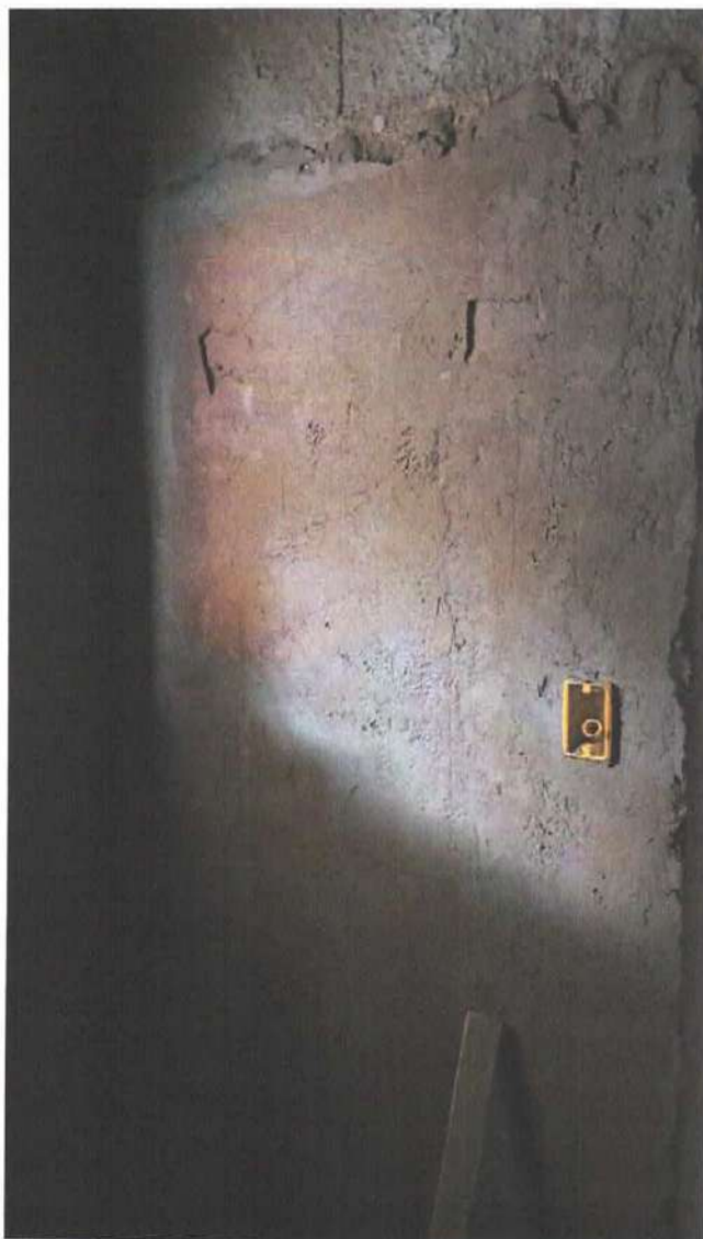
Foto 10: Instalação de caixinhas 4x2 de elétrica no 1º Pavimento
