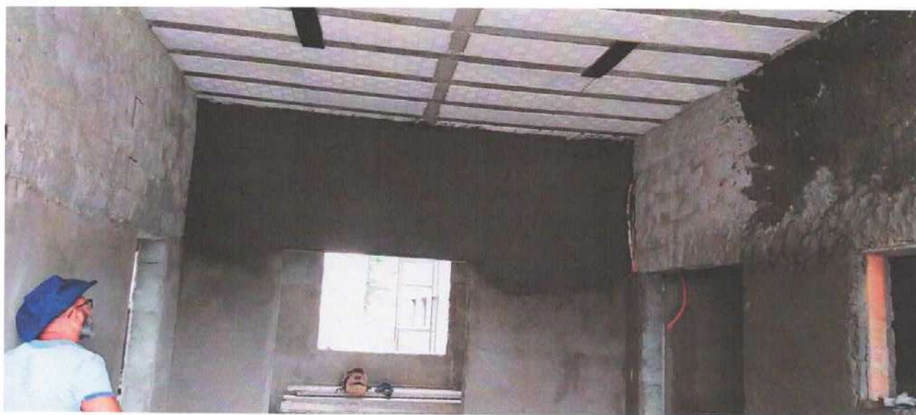
Foto 7: Emboço do 1º Pavimento
