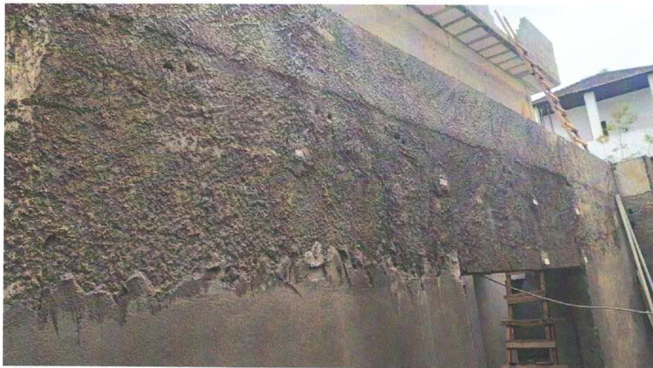
Foto 1: Chapisco e taliscas das paredes externas
