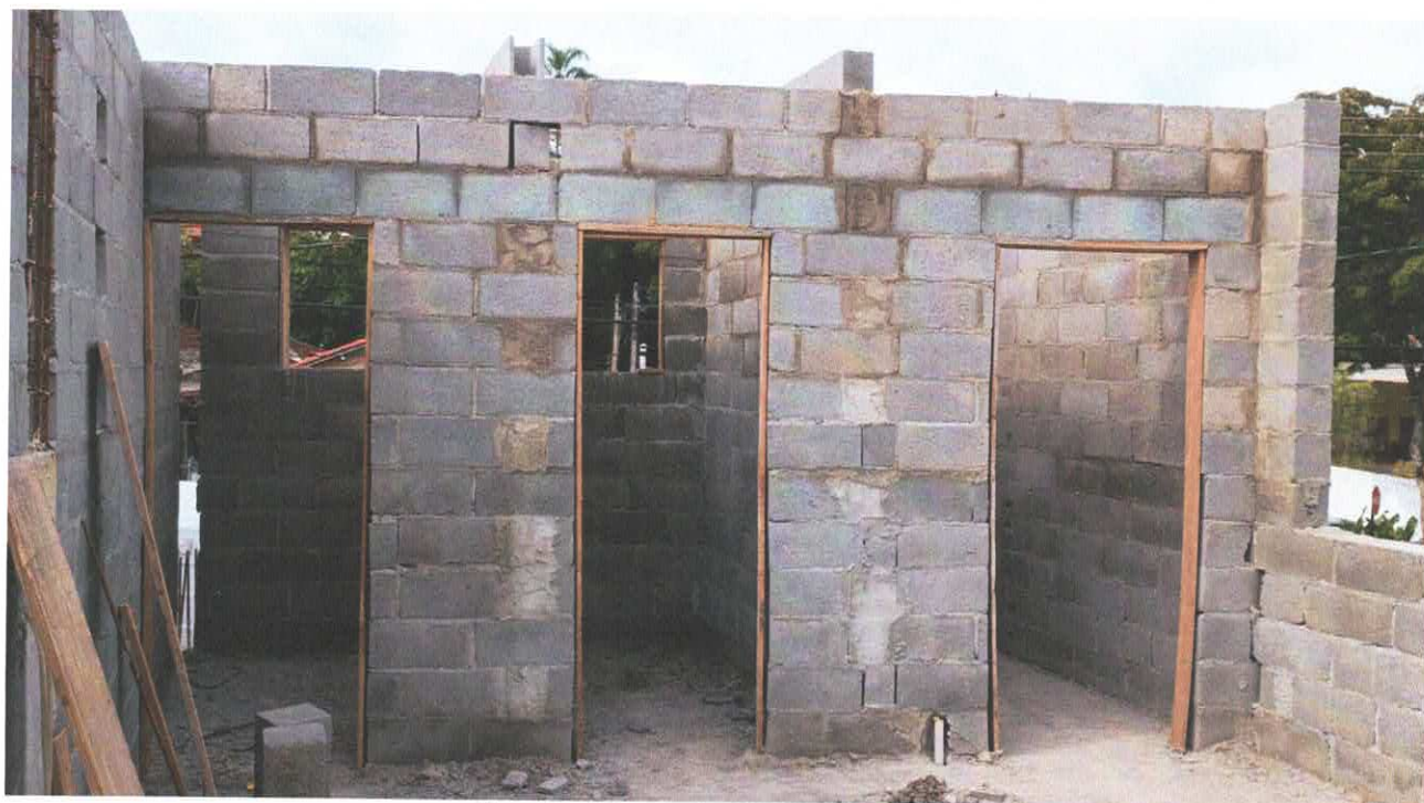
Foto 3: Alvenaria do 2º Pavimento
