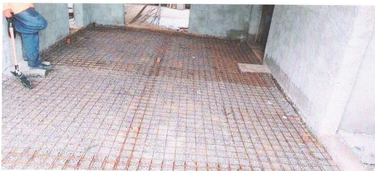
Foto 5: Preparação com lastro de brita e malha pop para a concretagem
