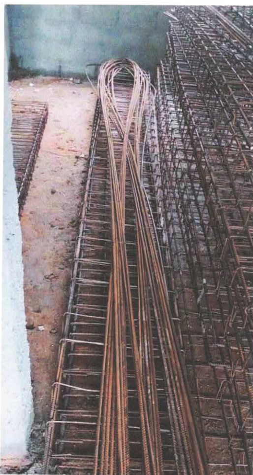
Foto 1: Ferragem das vigas e pilares
