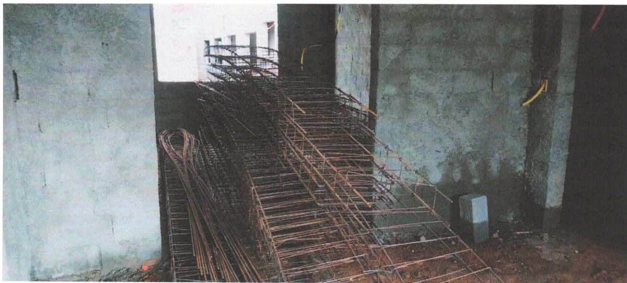
Foto 2: Ferragem das vigas e pilares
