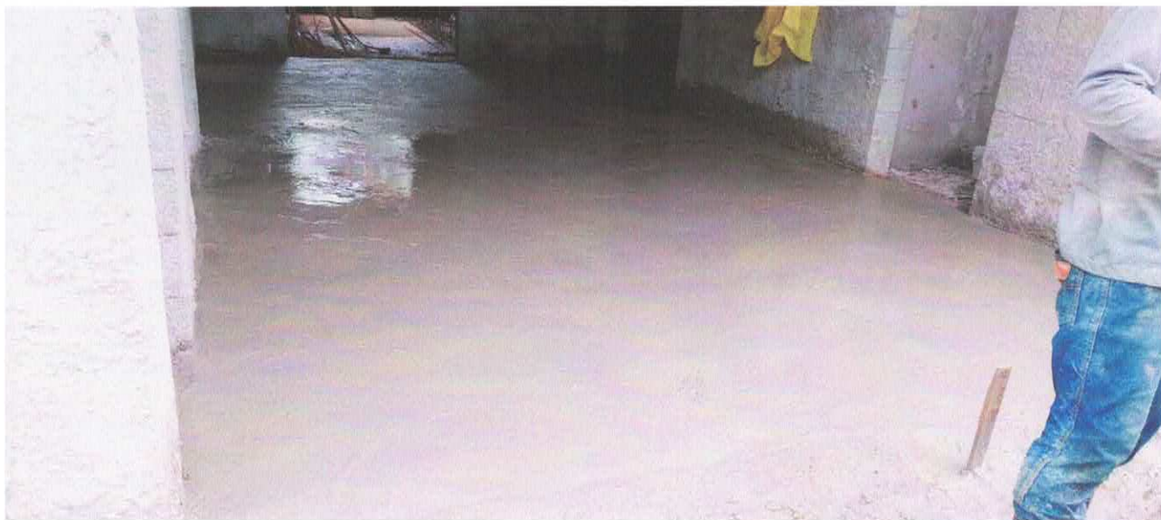
Foto 6: Concretagem do piso do 1º Pavimento
