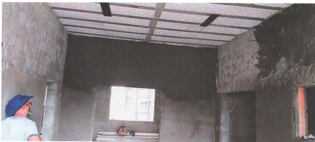
Foto 7: Emboço do 1º Pavimento
