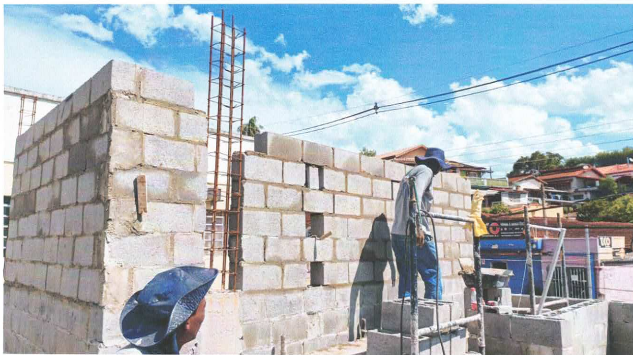
Foto 4: Alvenaria do 2º Pavimento
