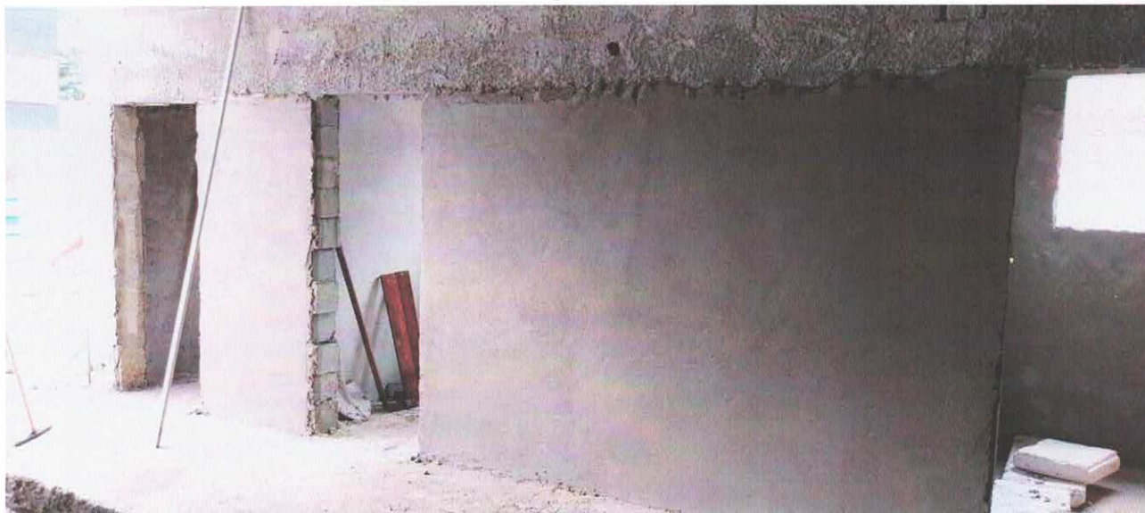
Foto 8: Reboco do 1º Pavimento
