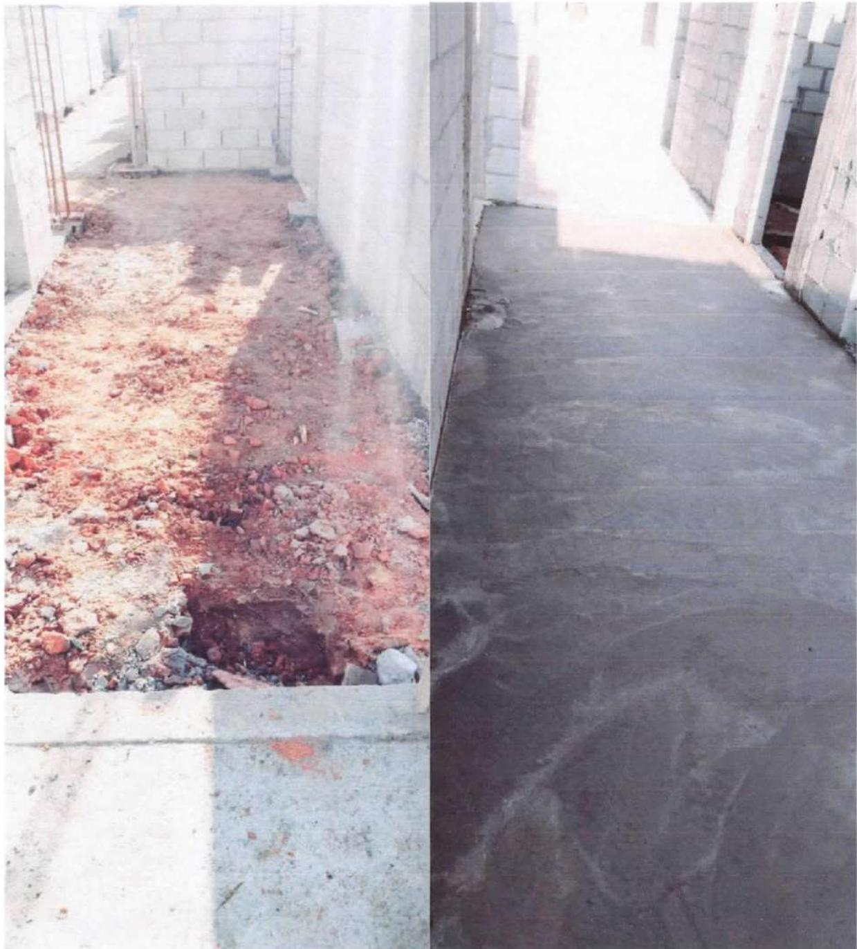
Foto 14 e 15: Preparação do terreno e concretagem do piso
