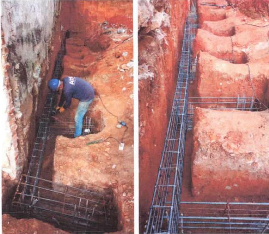
Foto 12 e 13: Execução da ferragem das vigas baldrame e dos blocos.
