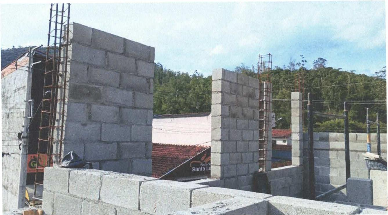
Foto 2: Alvenaria do 2º Pavimento
