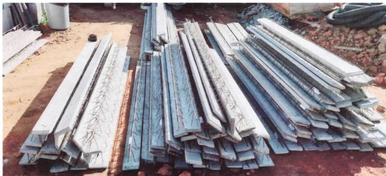
Foto 19: Vigotas treliçadas para montagem da laje
