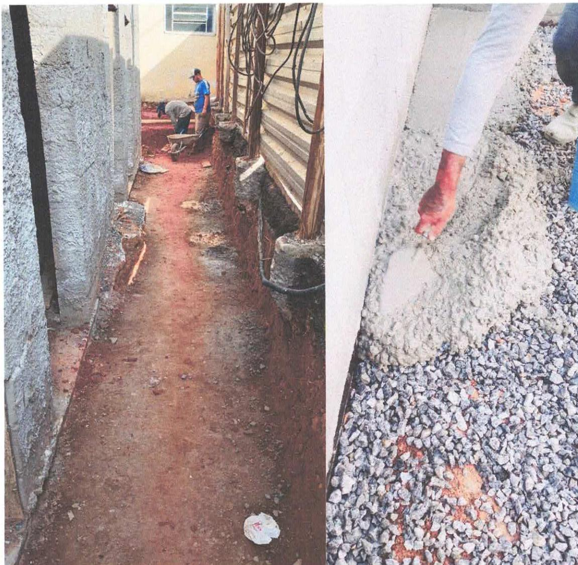
Foto 7 e 8: Regularização do terreno e concretagem da calçada
