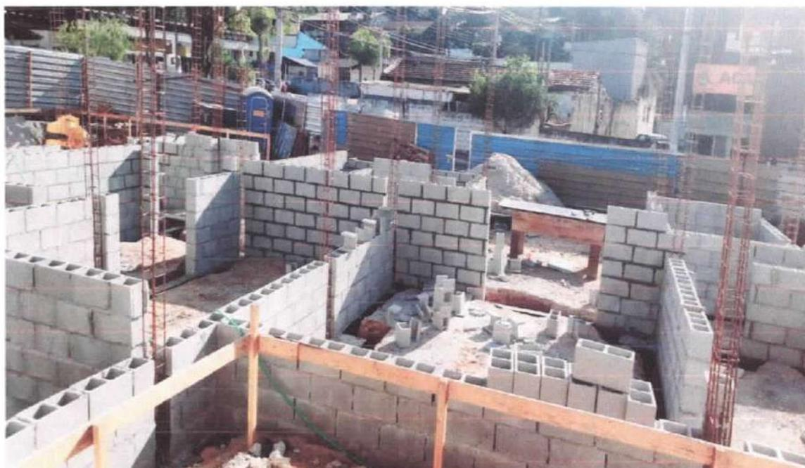
Foto 9: Assentamento da alvenaria de blocos de cimento
