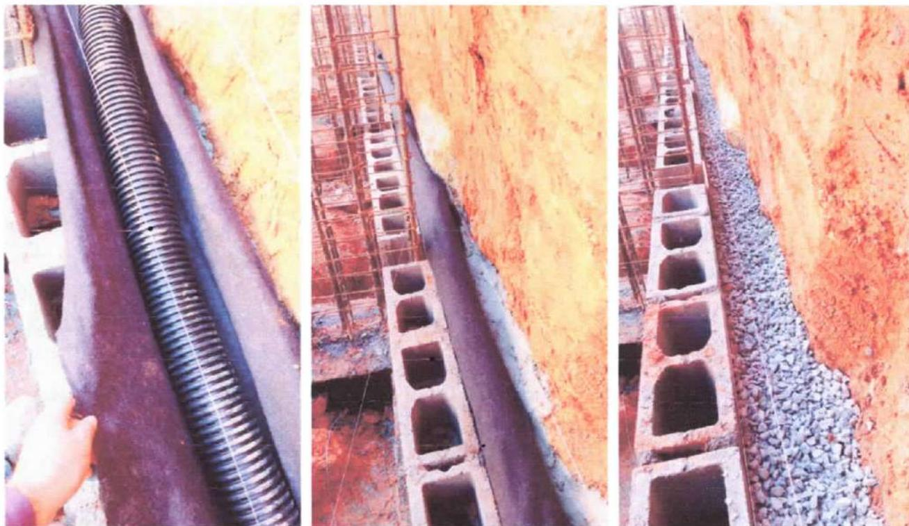
Foto 31, 32 e 33: Drenagem do muro de arrimo.
