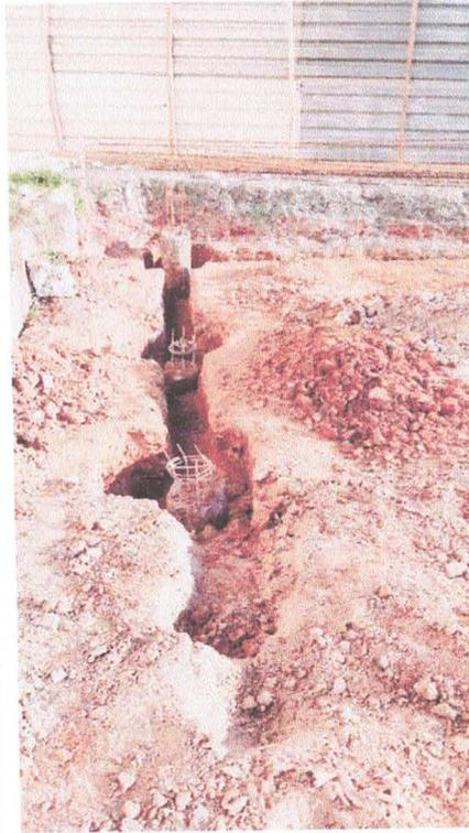
Foto 11 e 12: Abertura da viga baldrame e arrasamento da cabeça de estaca.
