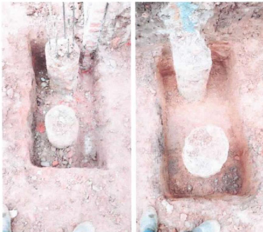
Foto 5 e 6: Escavação da fundação do muro de arrimo.
