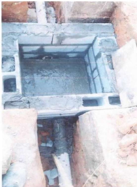
Foto 13: Tubulações e caixas de esgoto
