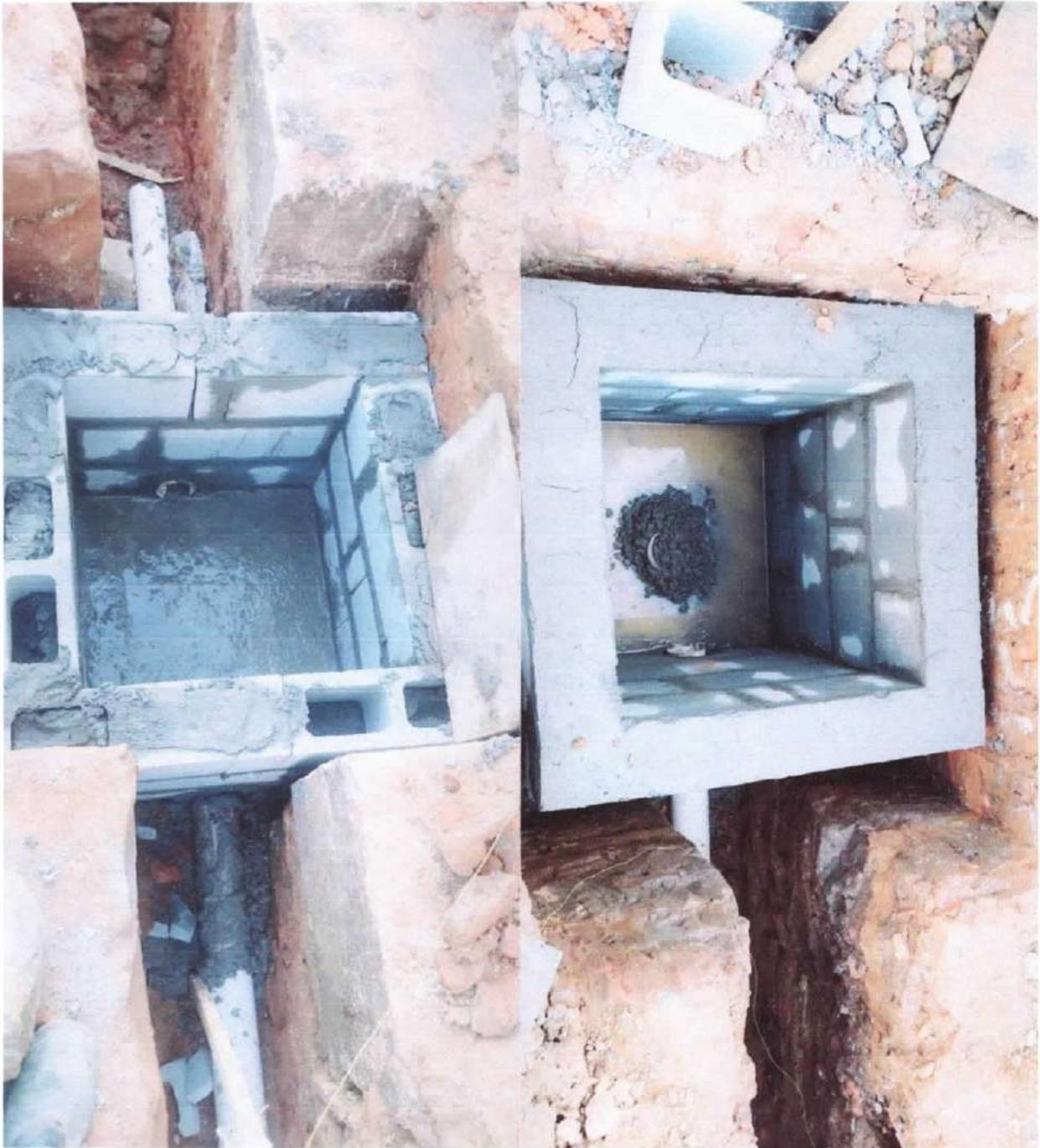
Foto 5 e 6: Finalização das alvenarias das caixas de esgoto
