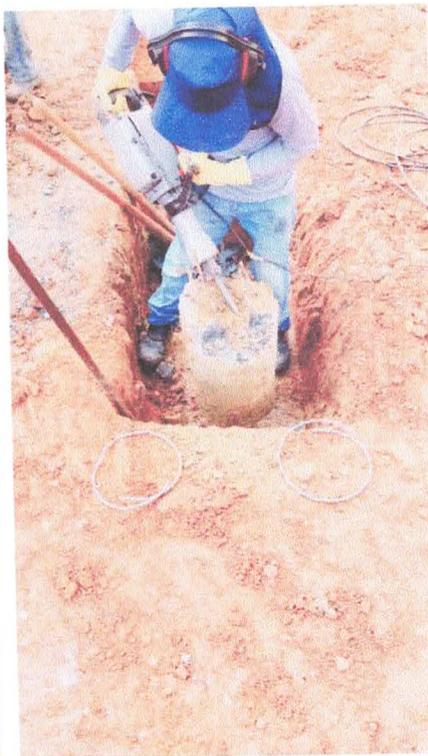
Foto 9 e 10: Abertura das sapatas e arrasamento da cabeça de estaca.
