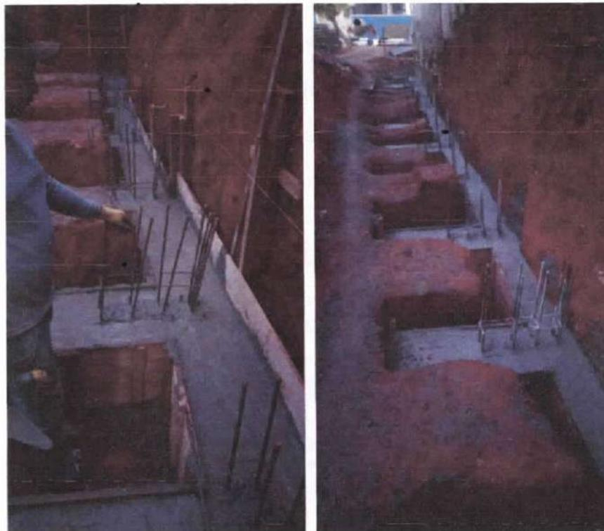
Foto 21 e 22: Concretagem das vigas baldrame e dos blocos.
