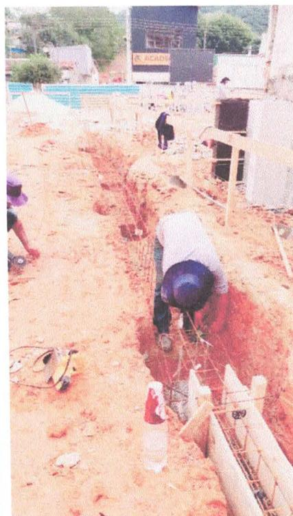
Foto 28 e 29: Montagem da ferragem e forma da viga baldrame.
