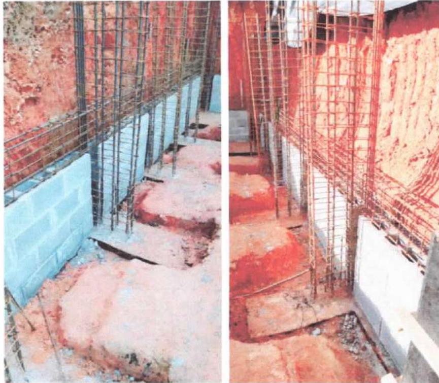
Foto 36 e 37: Execução da ferragem da viga intermediária.
