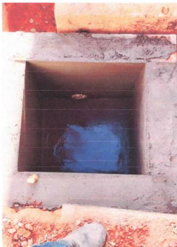
Foto 11: Reboco das caixas de esgoto
