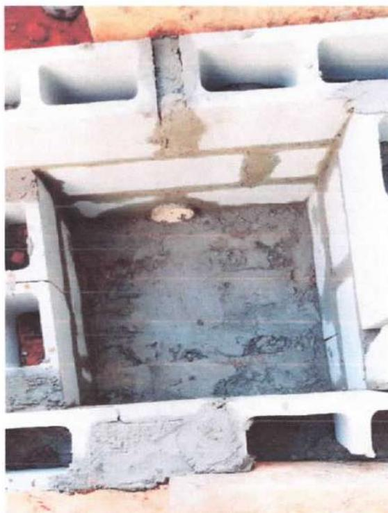
Foto 10: Alvenaria das caixas de esgoto
