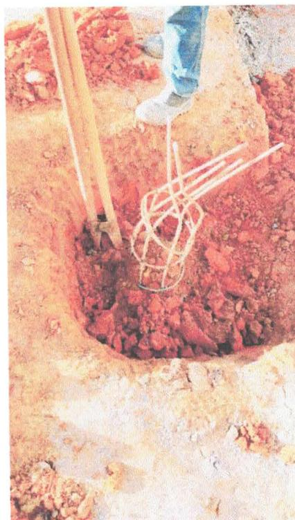
Foto 1 e 2: Abertura das sapatas e arrasamento da cabeça de estaca.
