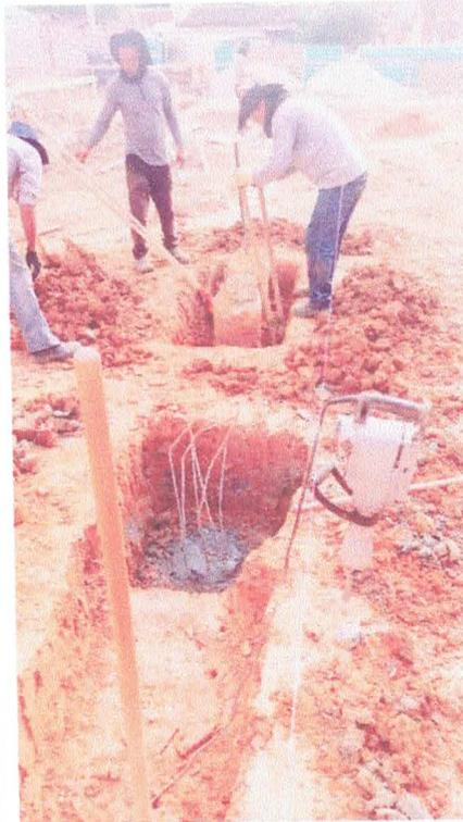
Foto 15 e 16: Abertura da viga baldrame e arrasamento da cabeça de estaca.
