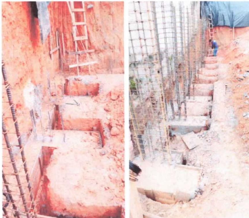
Foto 23 e 24: Execução da ferragem dos pilares.
