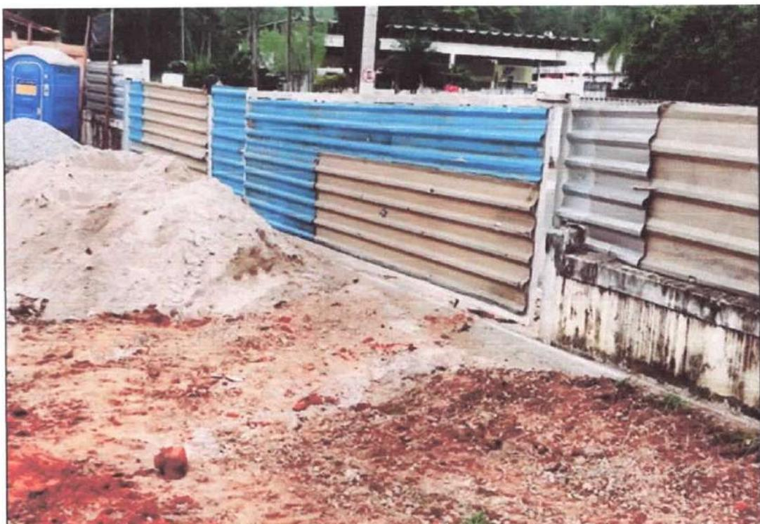
Foto 3. :Instalação de tapume na obra.
