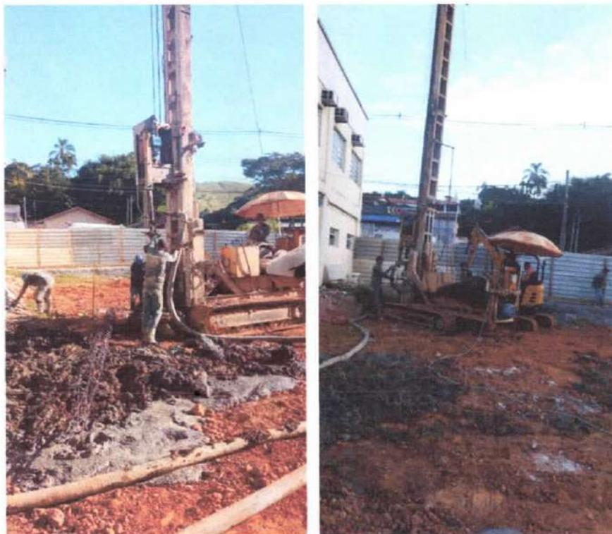
Foto 1 e 2: Execução estaca hélice.
