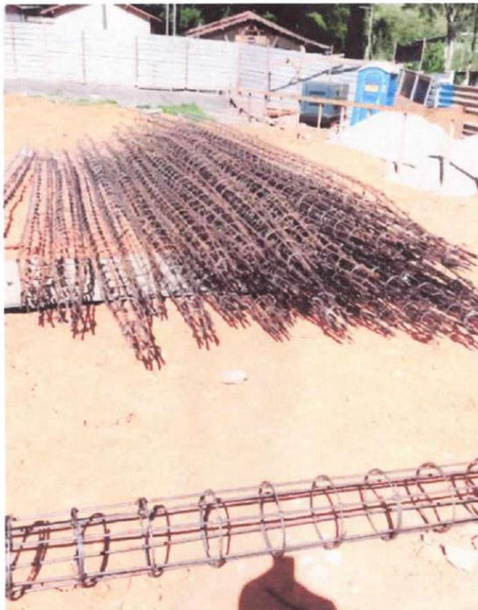
Foto 4.: Ferragem muro de arrimo.
