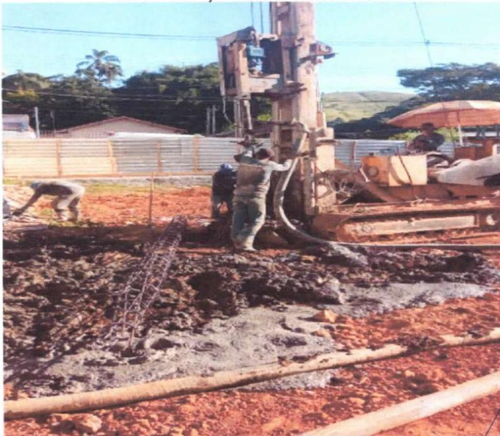
Foto 13.: Execução de estaca hélice contínua.
