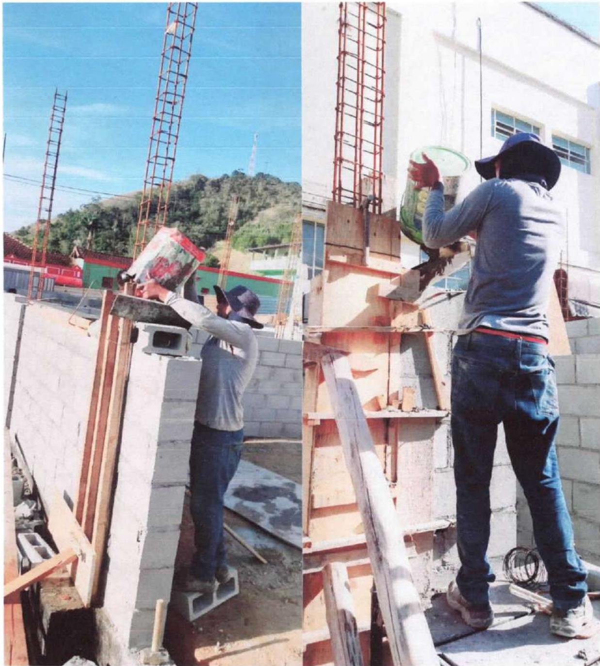
Foto 3 e 4: Concretagem dos pilares
