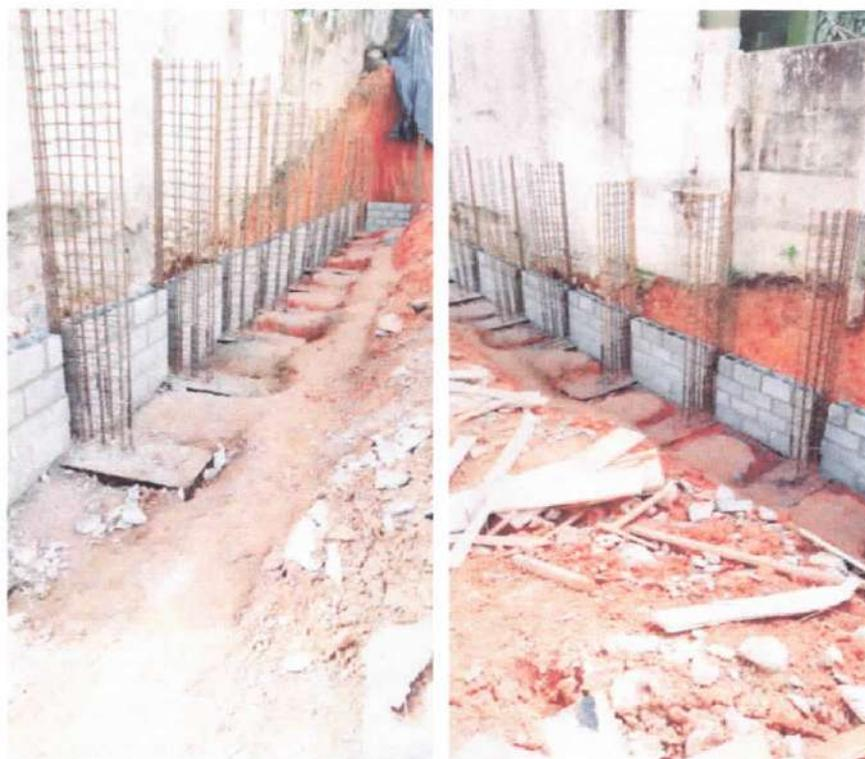
Foto 34 e 35: Elevação do muro de arrimo.
