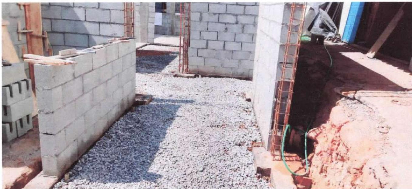
Foto 16: Preparação do terreno para concretagem do piso
