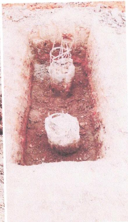
Foto 7 e 8: Abertura das sapatas e arrasamento da cabeça de estaca.
