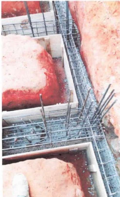
Foto 16: Execução da forma das vigas baldrame e dos blocos.
