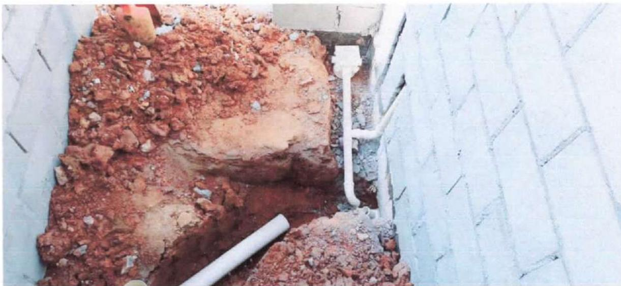
Foto 9: Escavação para colocação das caixas sifonadas e tubulação de esgoto
