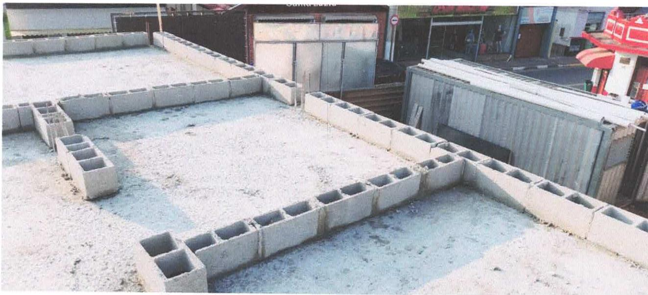
Foto 1: Marcação da alvenaria do 2º Pavimento
