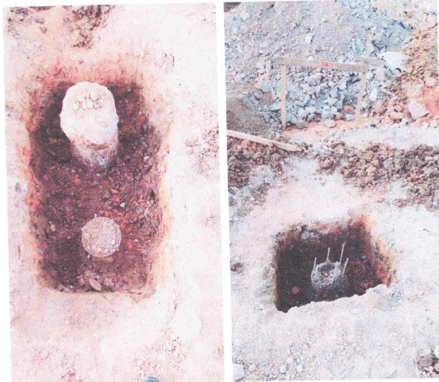
Foto 3 e 4: Abertura das sapatas e arrasamento da cabeça de estaca.
