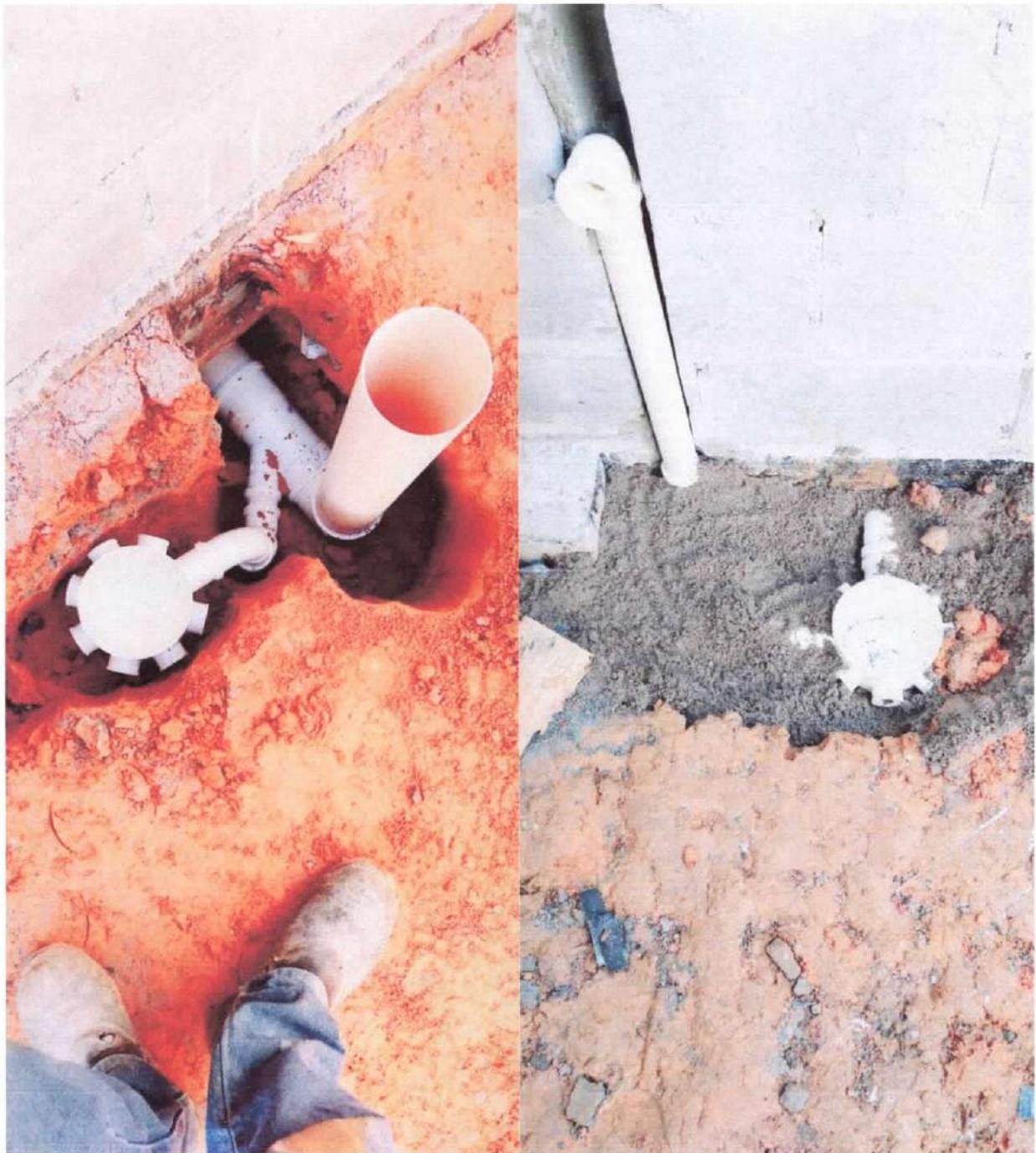
Foto 7 e 8: Escavação para colocação das caixas sifonadas e tubulação de esgoto
