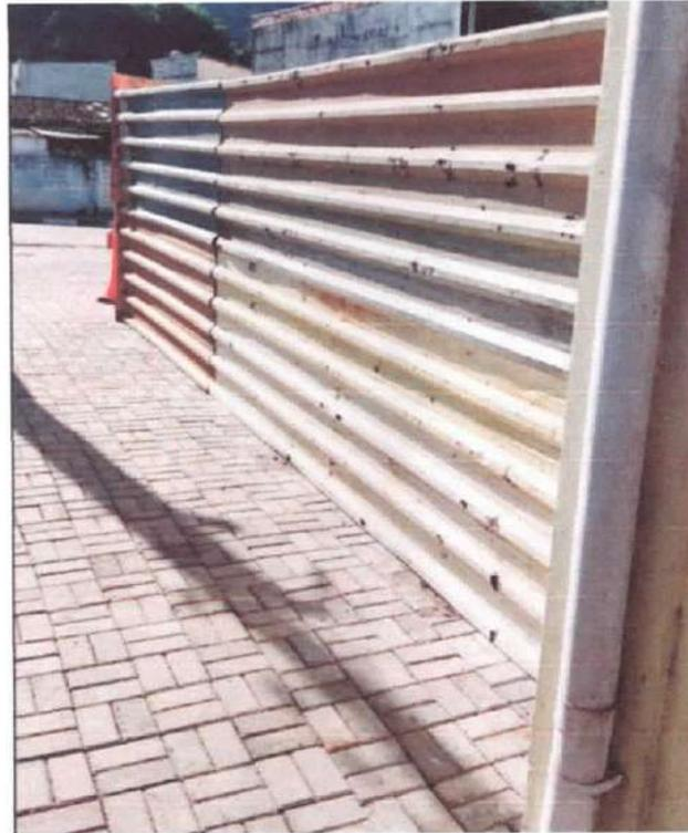
Foto 4.: Instalação de tapume na obra.
