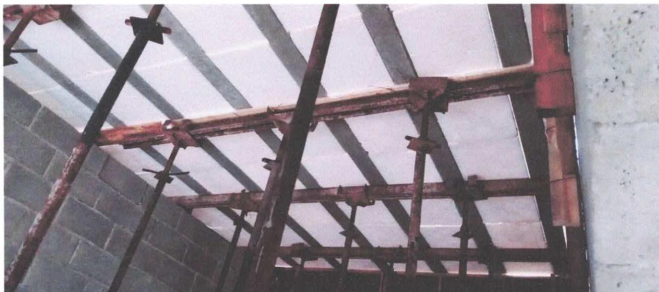
Foto 10: Colocação dos EPS e escoramento da laje
