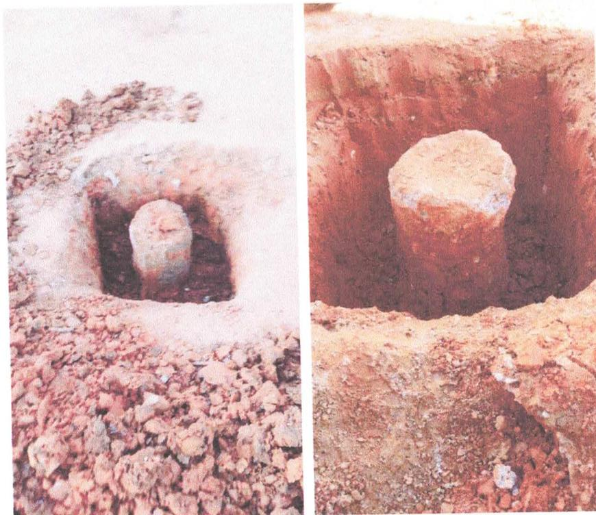
Foto 5 e 6: Abertura das sapatas e arrasamento da cabeça de estaca.
