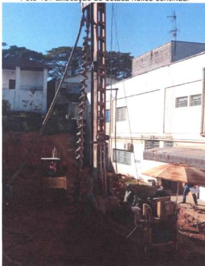
Foto 11.: Execução de estaca hélice contínua.
