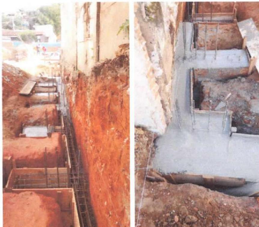
Foto 17 e 18: Concretagem das vigas baldrame e dos blocos.
