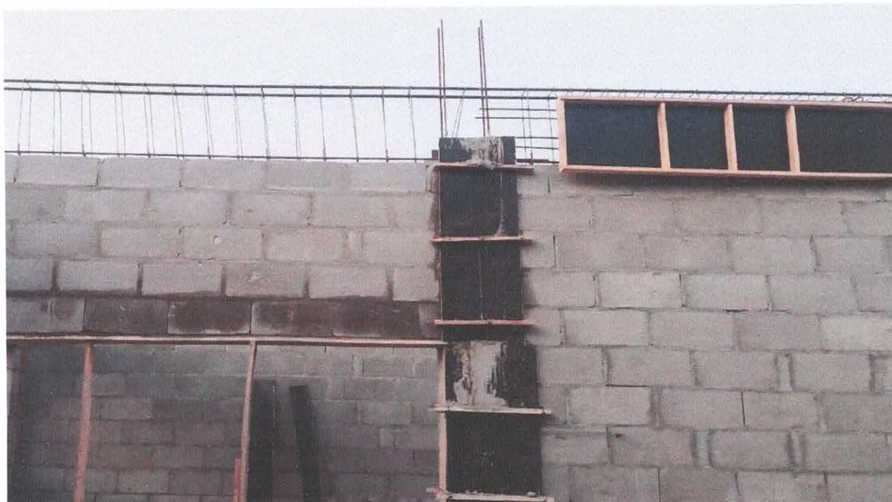
Foto 9: Colocação e fechamento das fôrmas das ferragens das vigas
