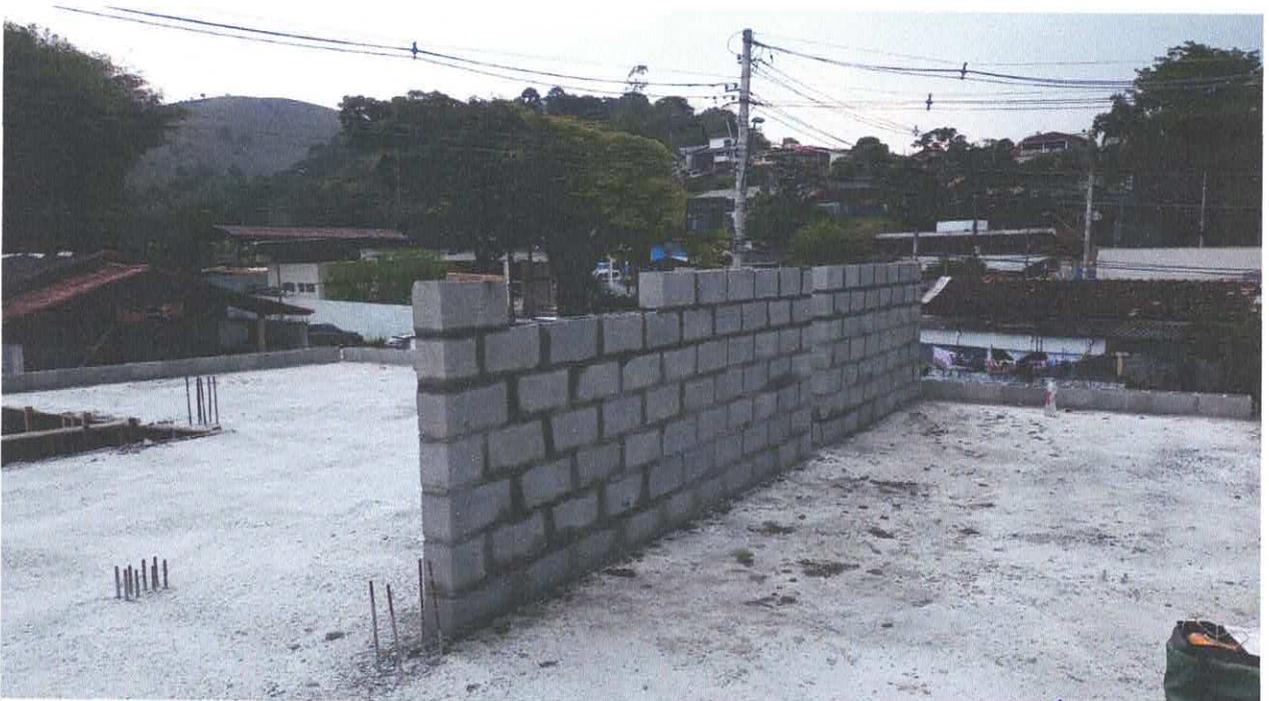
Foto 3: Elevação da alvenaria do 2º Pavimento
