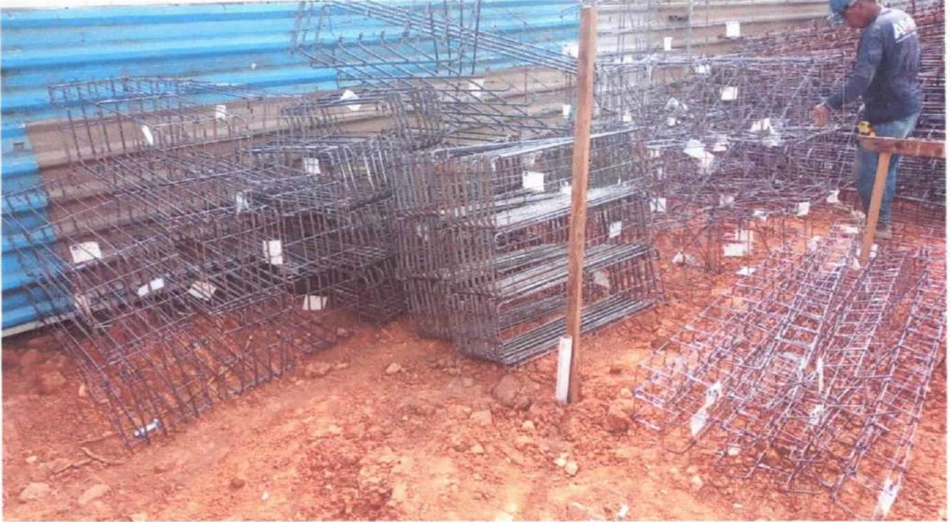
Foto 14.: Ferragem bloco de coroamento UPA e muro de arrimo.
