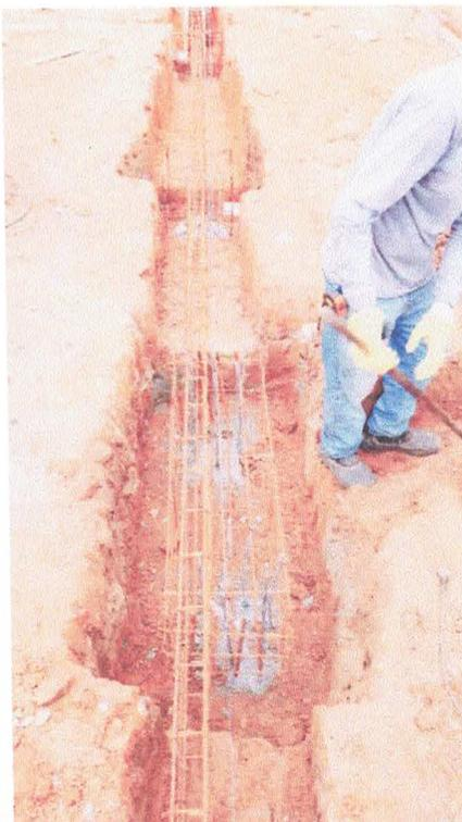
Foto 26 e 27: Montagem da ferragem da viga baldrame.
