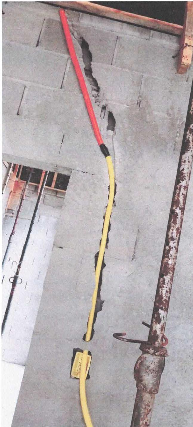
Foto 3: Passagem de corrugados para tomadas e interruptores do 1º Pavimento
