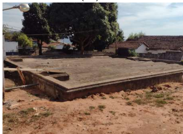
Figura 62: Reservatório semi-enterrado (R1).
