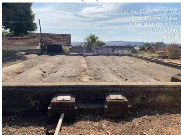
Figura 61: Reservatório semi-enterrado (R1).
