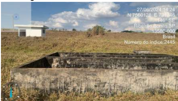
Figura 139: Estruturas da ETE 2.
