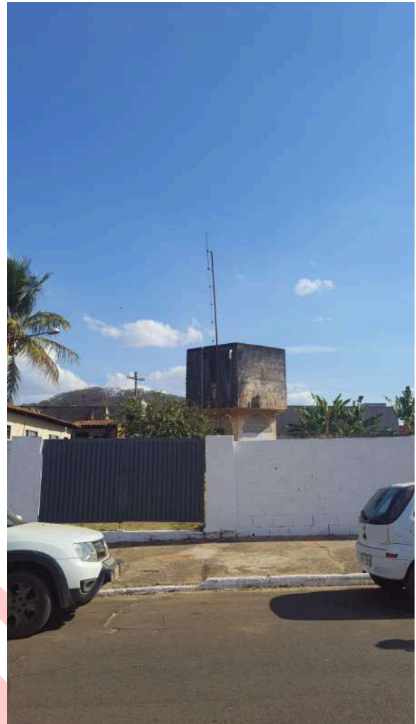
Figura 116: Poço (P9) Reservatório (R10).
