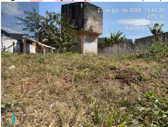
Figura 113: Poço (P9) Reservatório (R10).
