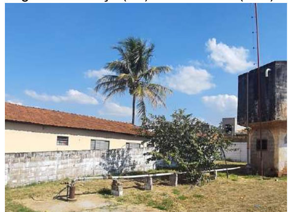
Figura 114: Poço (P9) Reservatório (R10).
