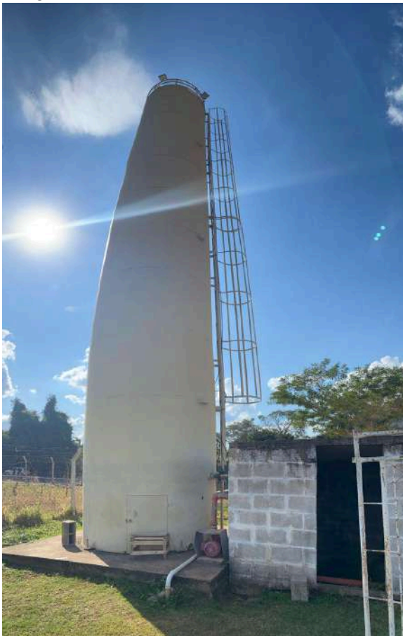
Figura 131: Reservatório elevado (R13).
