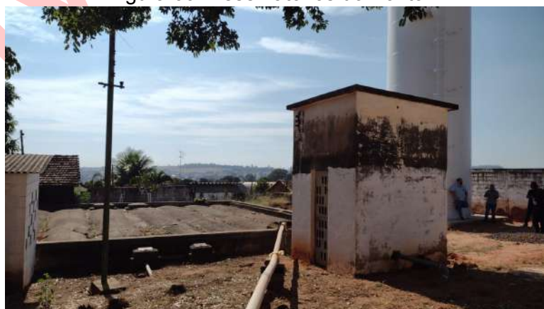
Figura 60: Reservatórios do Ponto 2.
