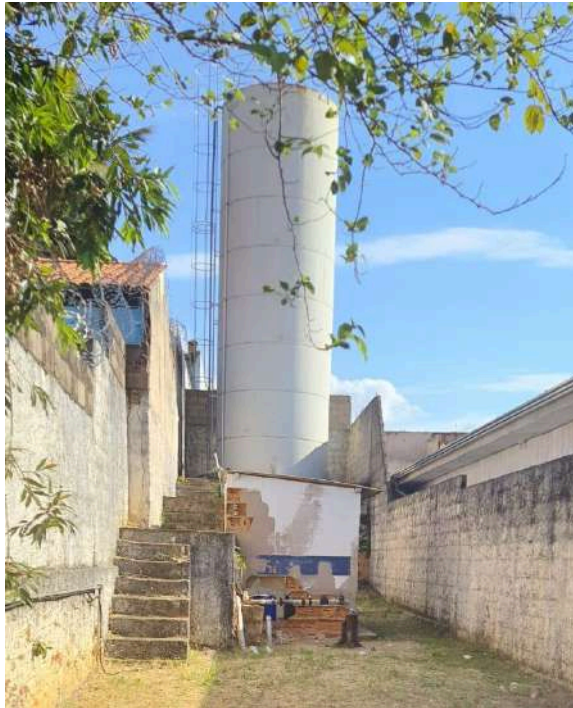
Figura 127: Poço (P11) Reservatório (R12).
