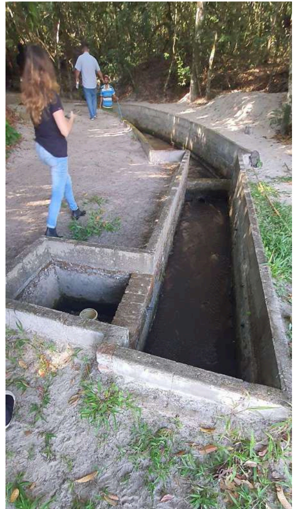
Figura 51: Limpeza manual do sistema.
