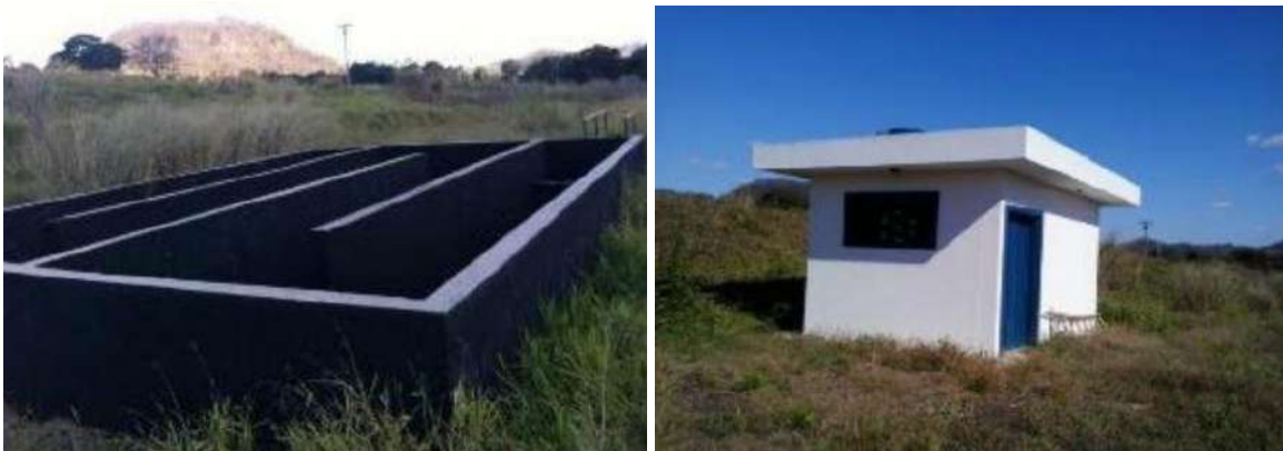
Figura 180 e 181. Chicanas e casa de química respectivamente
